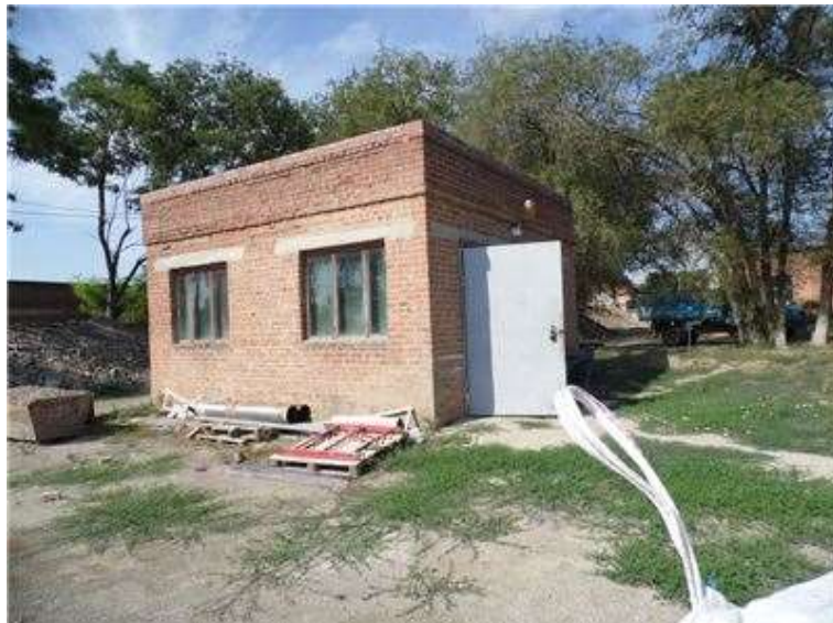
Фото.19 Литер Щ здание насосной
