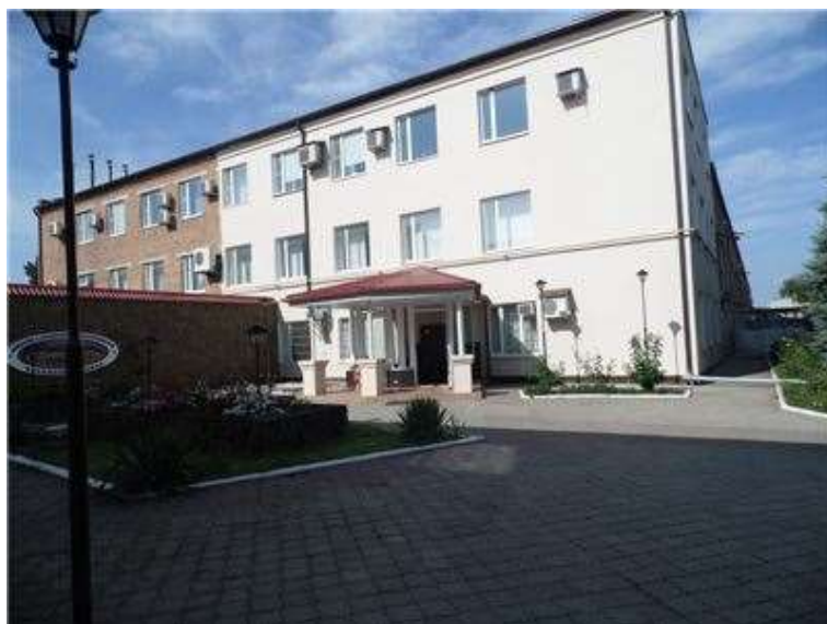
Фото.5 Литер А 3 Здание главного корпуса
