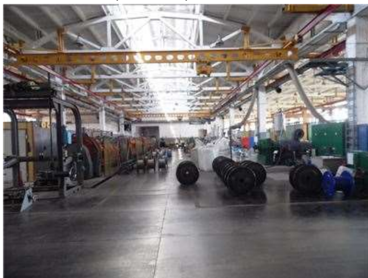
Фото.8 Литер А4, А5 Приемо-сдаточный цех 2
