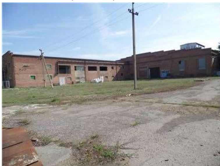
Фото.11 Литер А4, А5 Приемо-сдаточный цех 5
