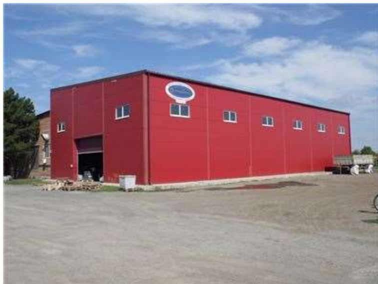
Фото.16 Литер Б Здание склада
