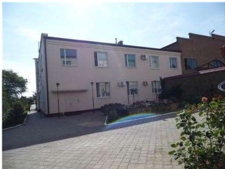
Фото.6 Литер А1 Здание Административного корпуса
