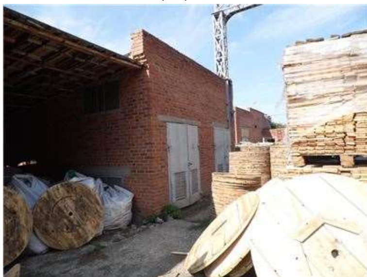
Фото.20 Литер Я здание электростанции
