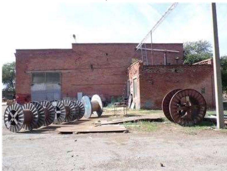
Фото.17 Литер Д,н-Д,д Здание производственного склада
