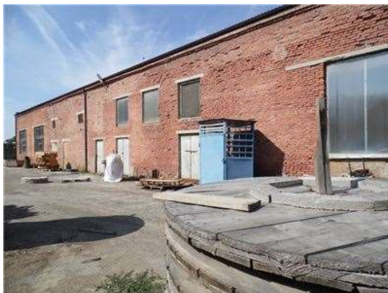
Фото.18 Литер Д,н-Д,д Здание производственного склада
