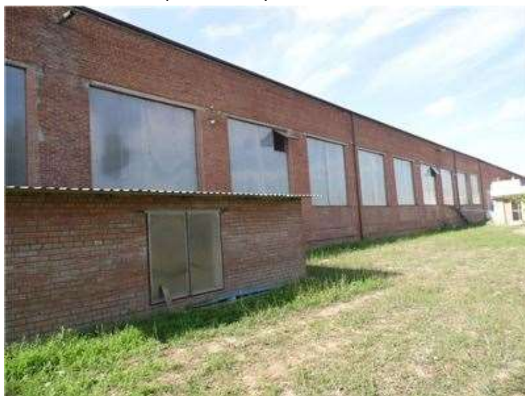
Фото.10 Литер А4, А5 Приемо-сдаточный цех 4
