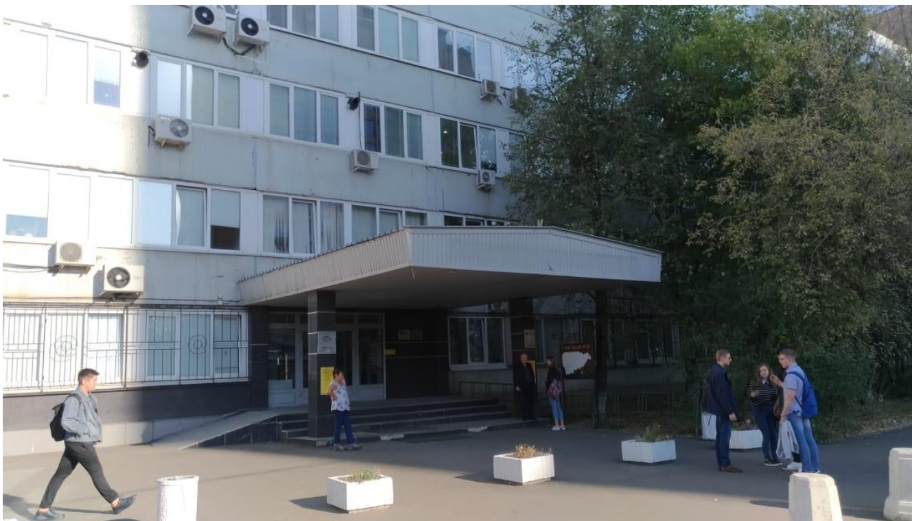
Фото.2 Внешний вид здания
