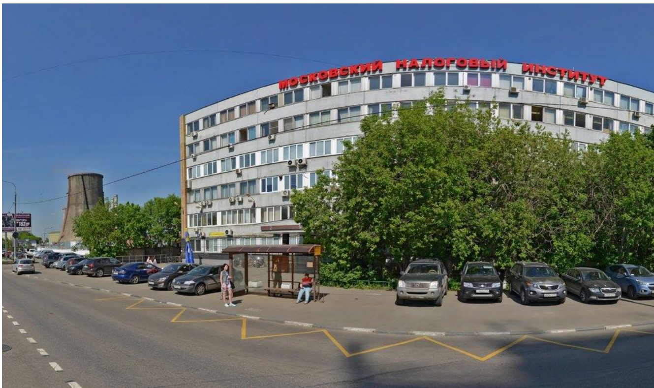
Фото.1 Внешний вид здания
