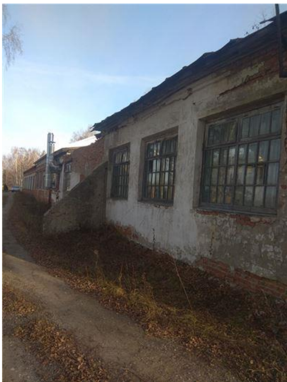
Фото.17 Здание механического цеха 4,лит Н.н
