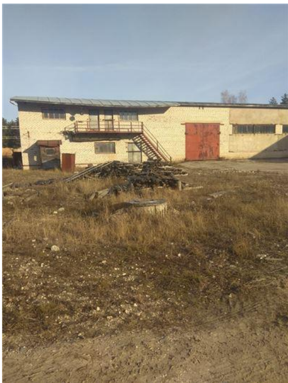
Фото.11 Здание материального склада 1,литР,Р
