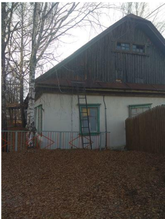
Фото.3 Здание конторы 1, лит.Х
