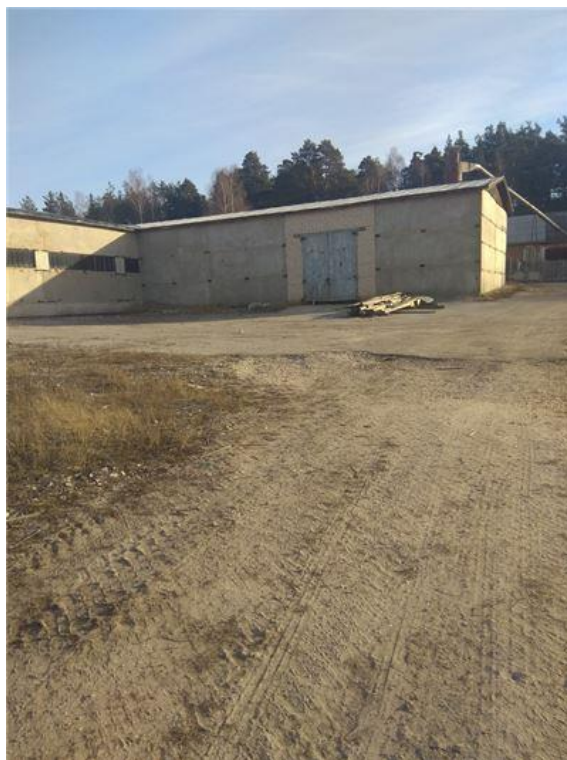
Фото.12 Здание материального склада 2,литР,Р
