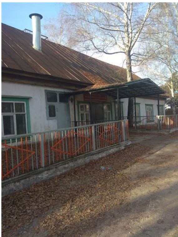
Фото.5 Здание конторы 3,лит.Х
