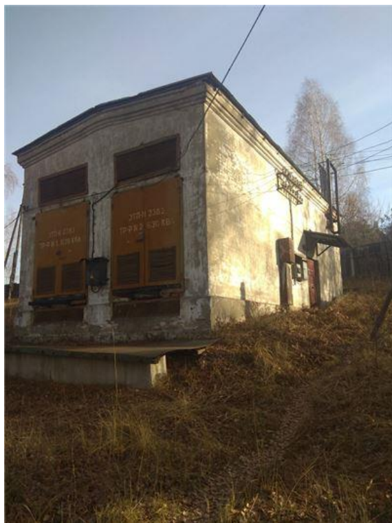
Фото.26 Здание трансформаторной подстанции 2,лит.Ж
