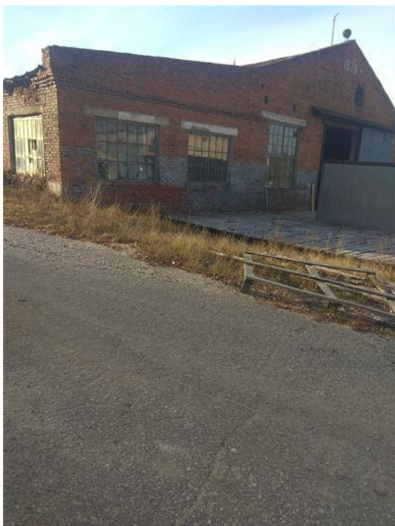
Фото.33 Здание цеха отделки кузовов 4,лит.М,м
