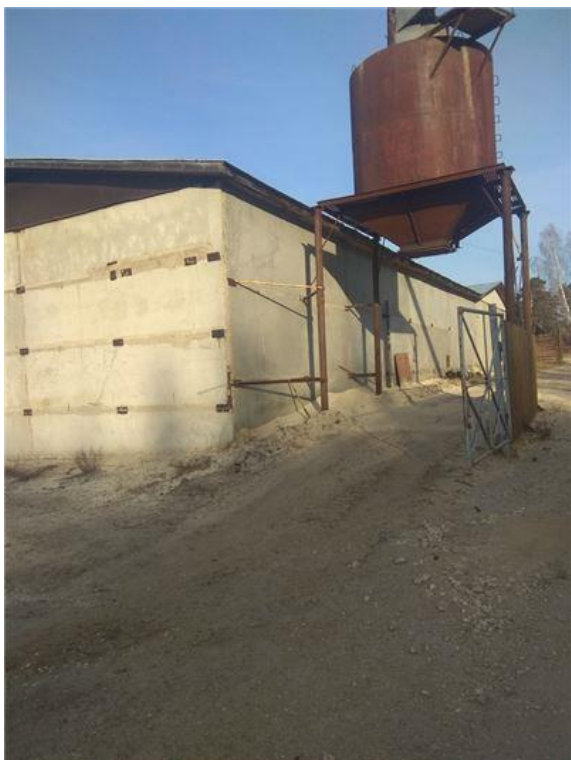
Фото.13 Здание материального склада 3,литР,Р
