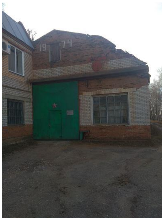
Фото.14 Здание механического цеха 1,лит Н.н
