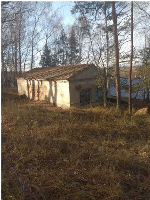
Фото.1 Здание компрессорной 1, лит 3
