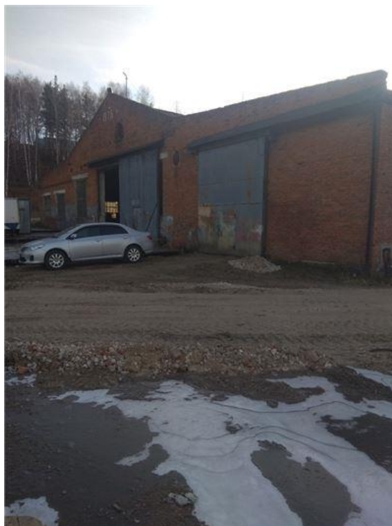
Фото.32 Здание цеха отделки кузовов 3,лит.М,м
