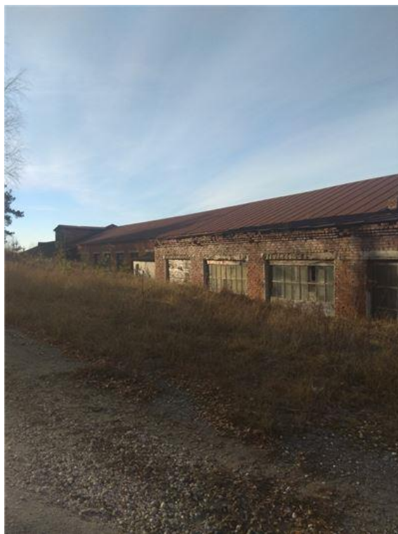
Фото.34 Здание цеха отделки кузовов 5,лит.М,м
