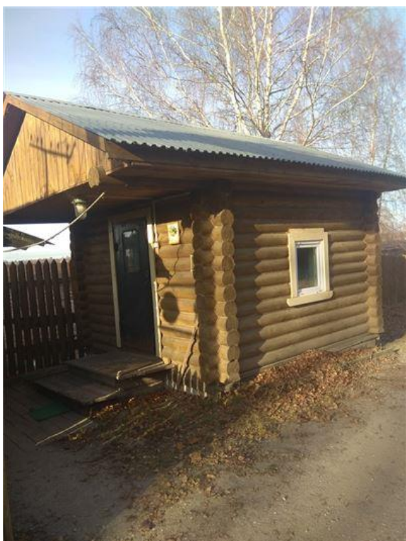
Фото.19 Здание проходной 2, лит.А, а
