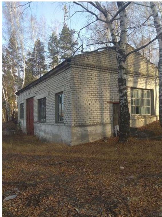
Фото.2 Здание компрессорной 2, лит, 3
