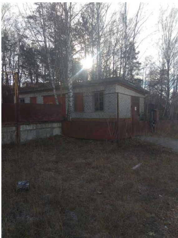
Фото.23 Здание склада ГСМ,лит.С
