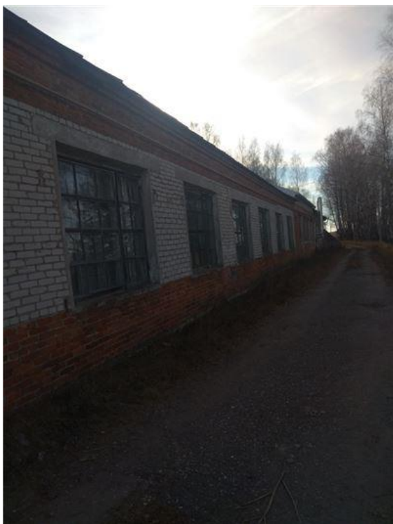
Фото.15 Здание механического цеха 2,лит Н.н
