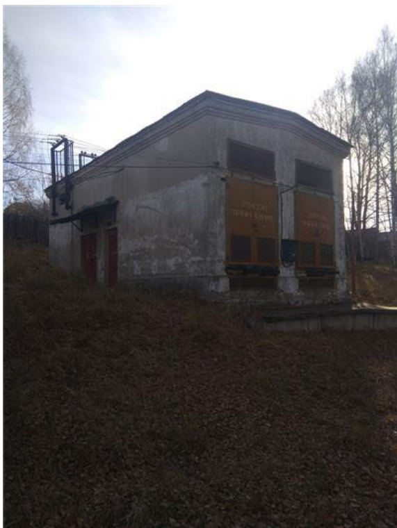
Фото.25 Здание трансформаторной подстанции 1,лит.Ж
