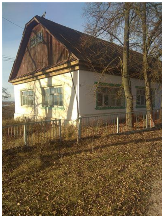
Фото.4 Здание конторы 2, лит.Х
