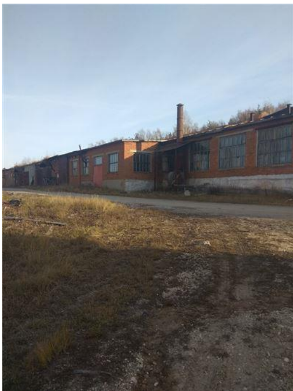
Фото.31 Здание цеха отделки кузовов 2,лит.М,м
