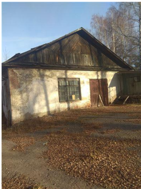
Фото.16 Здание механического цеха 3,лит Н.н
