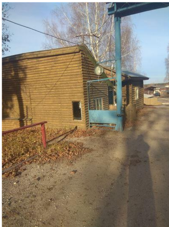
Фото.18 Здание проходной 1, лит.А, а
