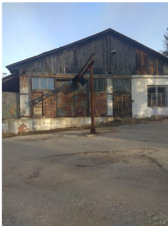
Фото.30 Здание цеха отделки кузовов 1,лит.М,м
