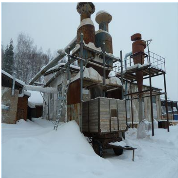
Рис. 11 Здание лесопильного и малярного цеха, лит. И,и,и1,и2,и3,и4,и5 (5)
