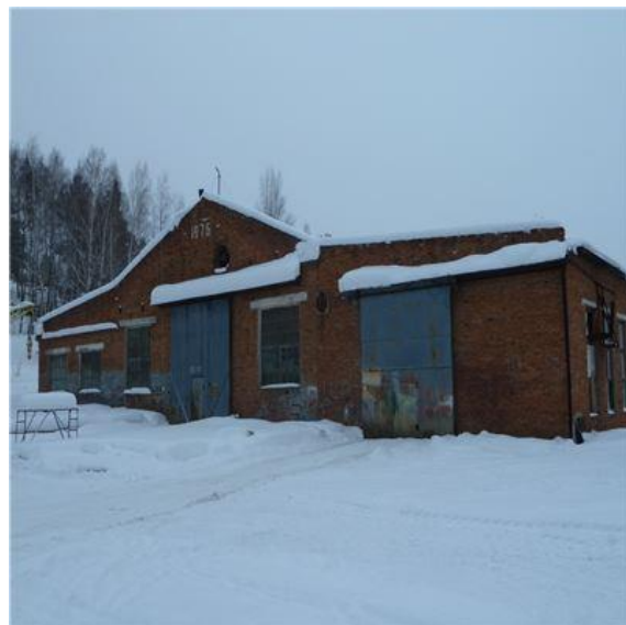
Рис. 22 Здание сборочного цеха, лит. О.о (1)
