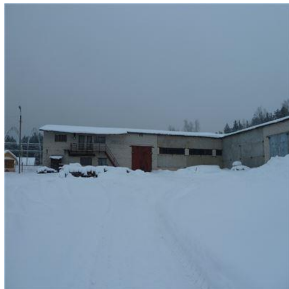
Рис. 12 Здание материального склада, лит. Р.Р1.р (1)
