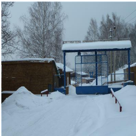
Рис. 21 Здание проходной, лит.А, а (3)
