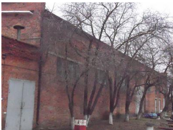
Фото.17 Литер Д,нД,д Здание производственного склада
