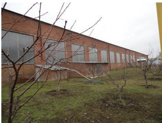
Фото.13 Литер А4,А5 Приемо-сдаточный цех
