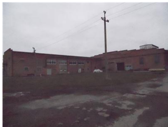
Фото.12 Литер А4,А5 Приемо-сдаточный цех
