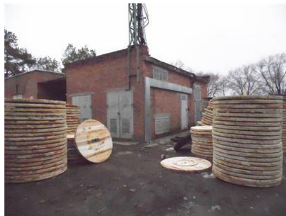
Фото.20 Литер Я Здание электростанции
