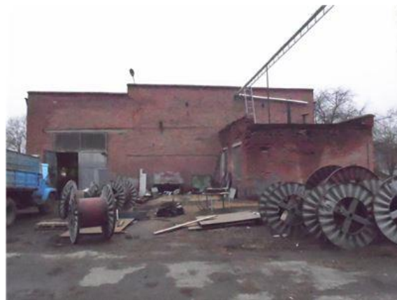
Фото.18 Литер Д,нД,д Здание производственного склада
