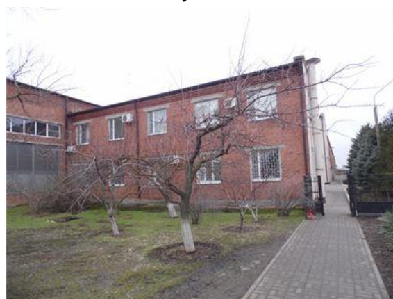
Фото.6 Литер А1 Административный корпус
