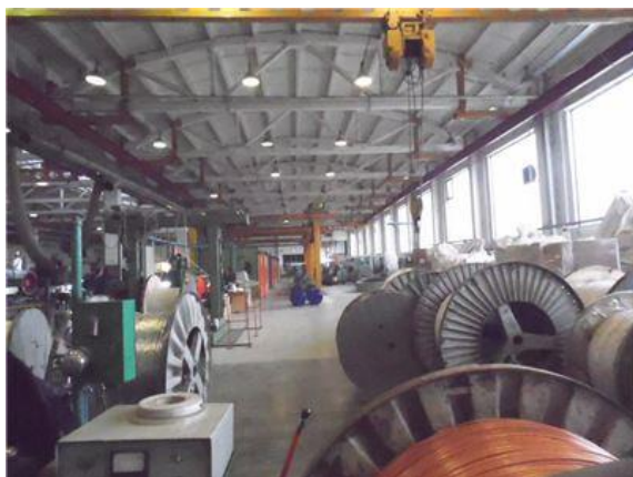
Фото.11 Литер А4,А5 Приемо-сдаточный цех
