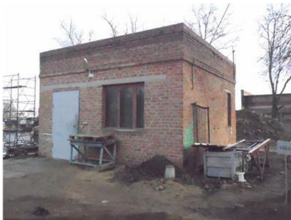
Фото.19 Литер Щ здание насосной
