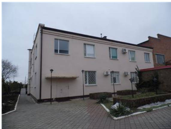
Фото.7 Литер А1 Административный корпус
