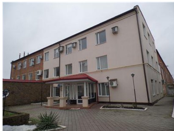
Фото.8 Литер А3 Главный корпус
