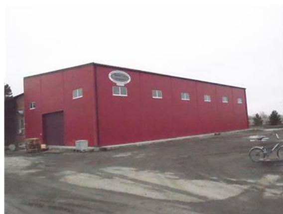
Фото.16 Литер Б Здание склада
