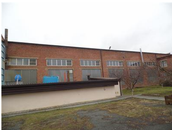
Фото.15 Литер Аа Разборочный цех
