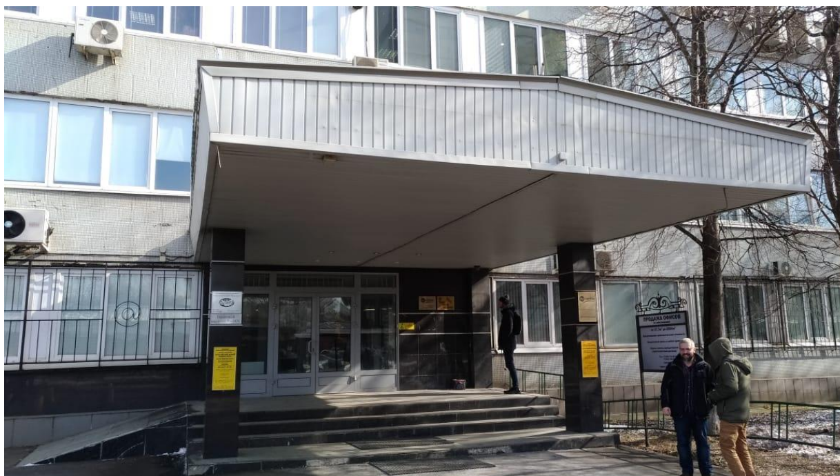
Фото.2 Внешний вид здания
