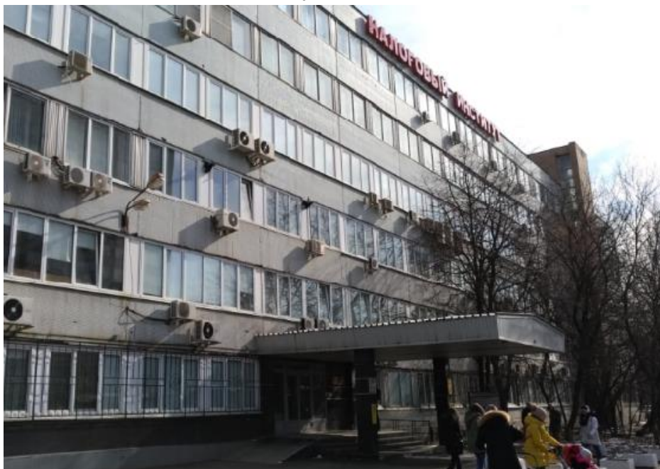
Фото.1 Внешний вид здания
