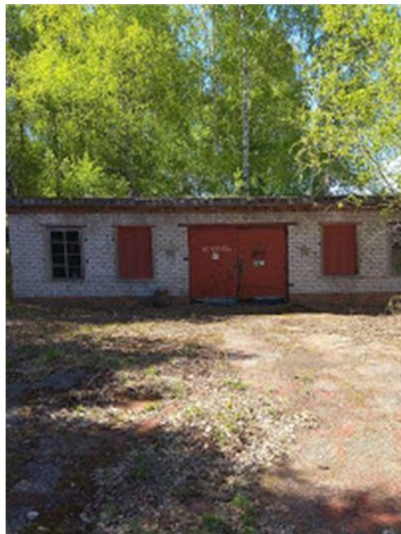
Фото.26 Здание склада ГСМ, лит.С (2)
