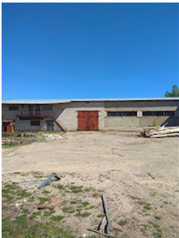
Фото.13 Здание материального склада, лит. Р.Р1.р (2)
