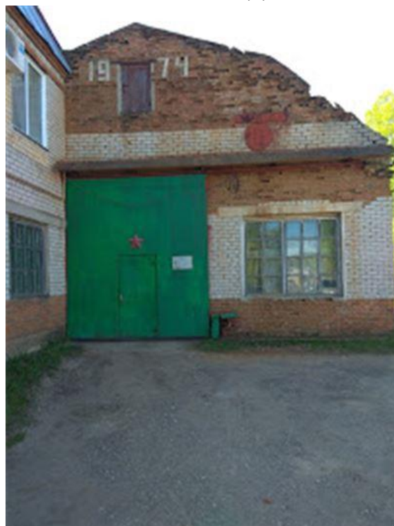
Фото.16 Здание механического цеха, лит. Н.н (1)
