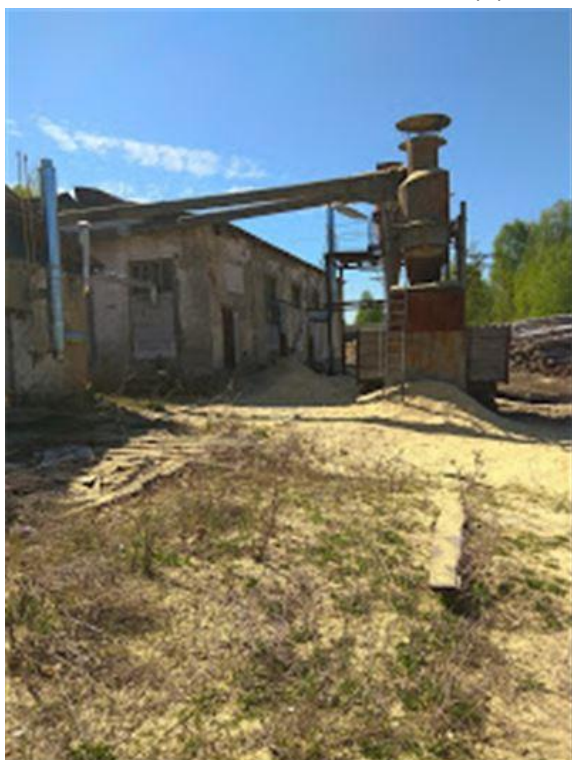
Фото.11 Здание лесопильного и малярного цеха, лит. И,и,и1,и2,и3,и4,и5 (5)
