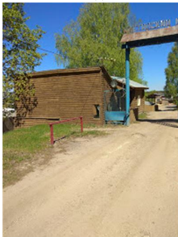
Фото.20 Здание проходной, лит.А, а (2)
