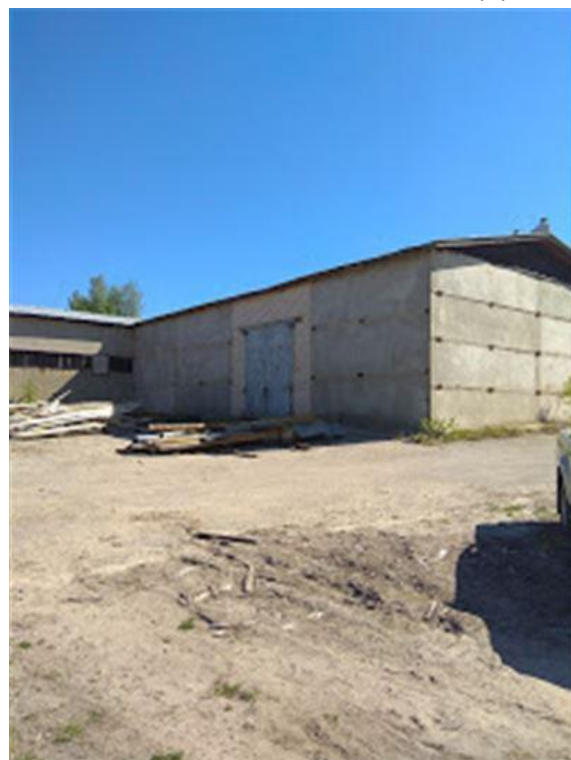
Фото.12 Здание материального склада, лит. Р.Р1.р (1)
