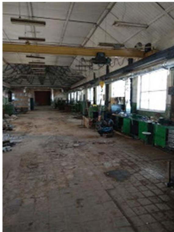
Фото.18 Здание механического цеха, лит. Н.н (3)
