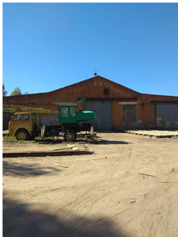
Фото.36 Здание цеха отделки кузовов, лит. М.м (2)
