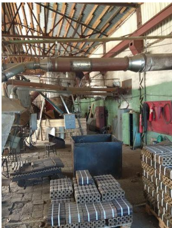
Фото.33 Здание участка сборки транспортеров, лит.К (3)
