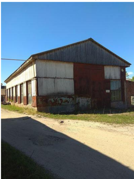
Фото.31 Здание участка сборки транспортеров, лит.К (1)
