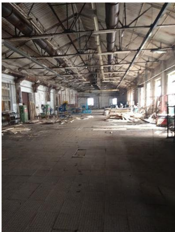
Фото.23 Здание сборочного цеха, лит. О.о (3)
