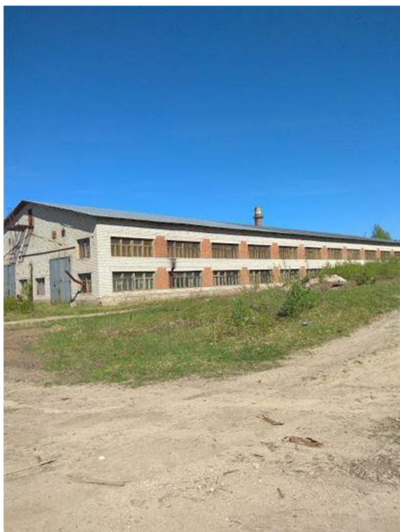
Фото.21 Здание сборочного цеха, лит. О.о (1)
