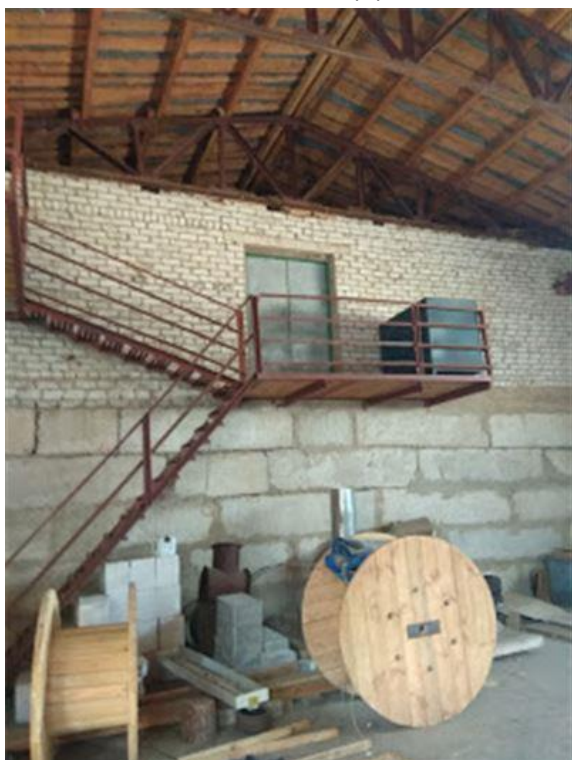
Фото.15 Здание материального склада, лит. Р.Р1.р (4)
