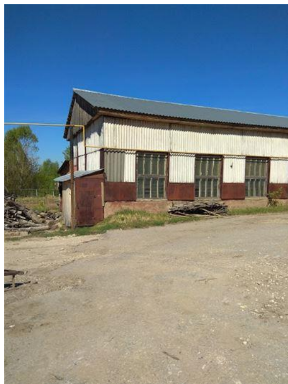
Фото.34 Здание участка сборки транспортеров, лит.К (4)
