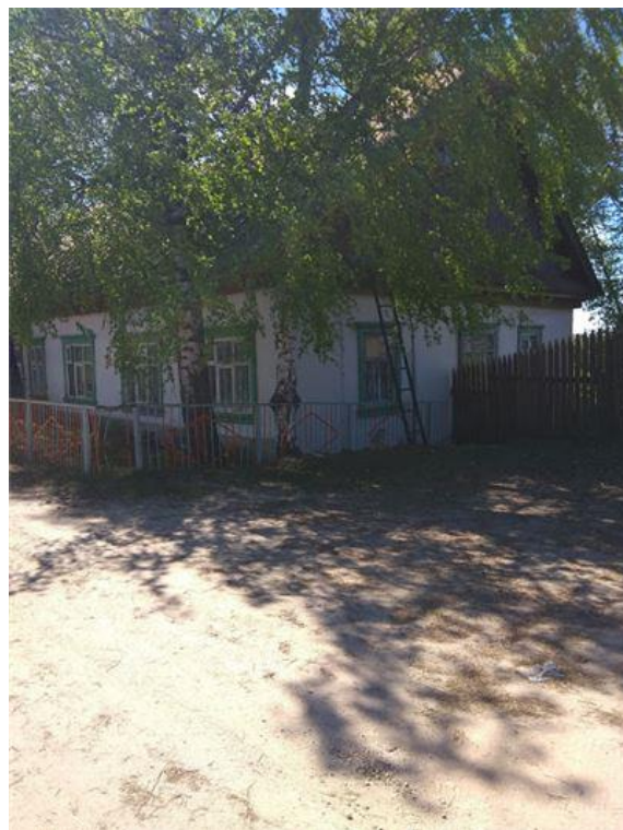
Фото.4 Здание конторы, лит.Х (1)
