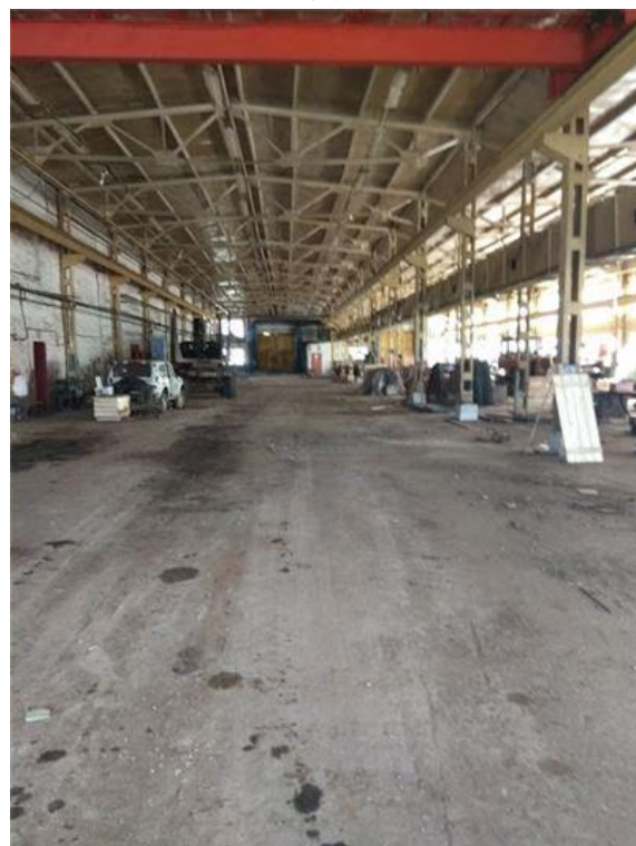
Фото.24 Здание сборочного цеха, лит. О.о (4)
