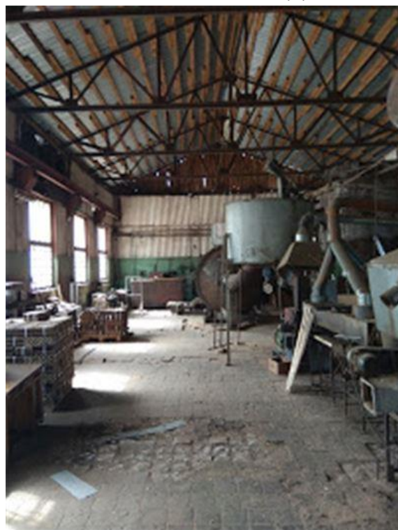
Фото.32 Здание участка сборки транспортеров, лит.К (2)
