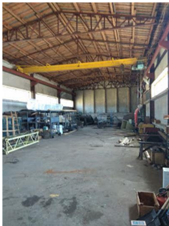
Фото.14 Здание материального склада, лит. Р.Р1.р (3)
