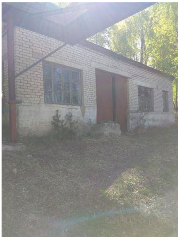
Фото.1 Здание компрессорной, лит.3 (1)
