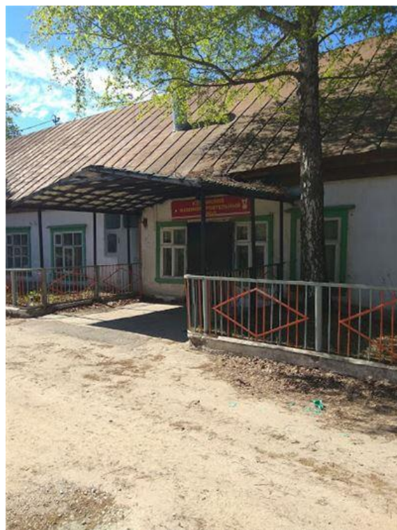
Фото.6 Здание конторы, лит.Х (3)
