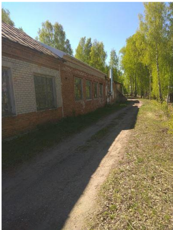
Фото.17 Здание механического цеха, лит. Н.н (2)
