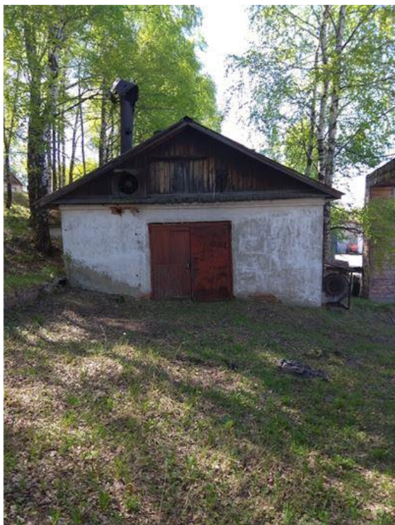
Фото.3 Здание компрессорной, лит.3 (3)
