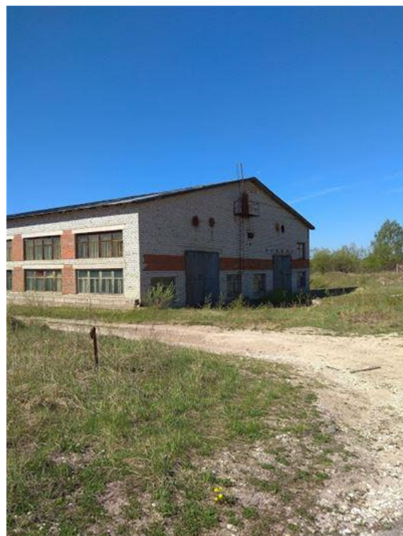
Фото.22 Здание сборочного цеха, лит. О.о (2)
