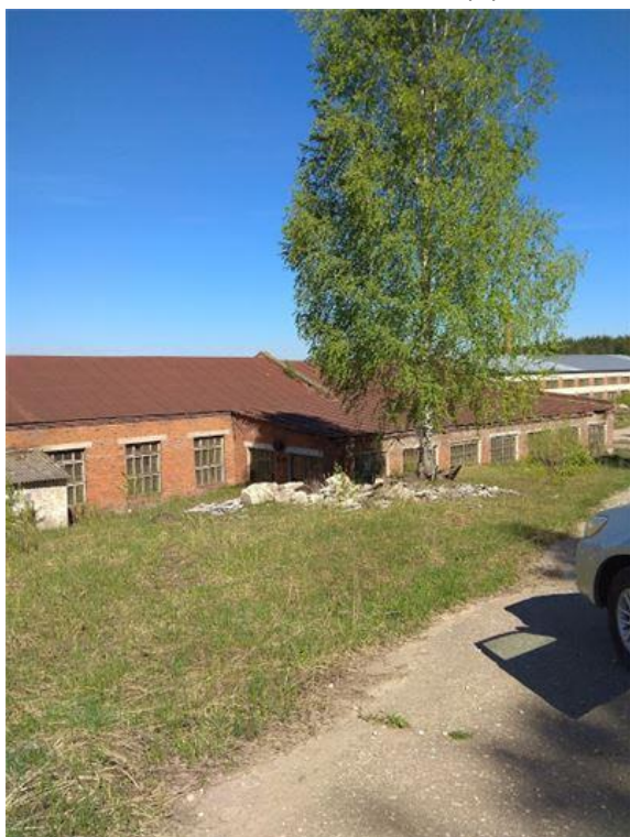
Фото.35 Здание цеха отделки кузовов, лит. М.м (1)
