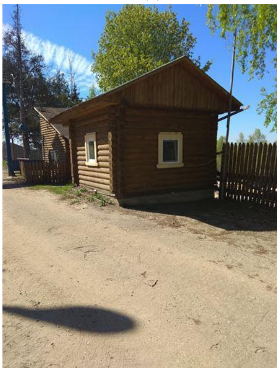
Фото.19 Здание проходной, лит.А, а (1)
