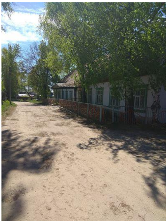
Фото.5 Здание конторы, лит.Х (2)
