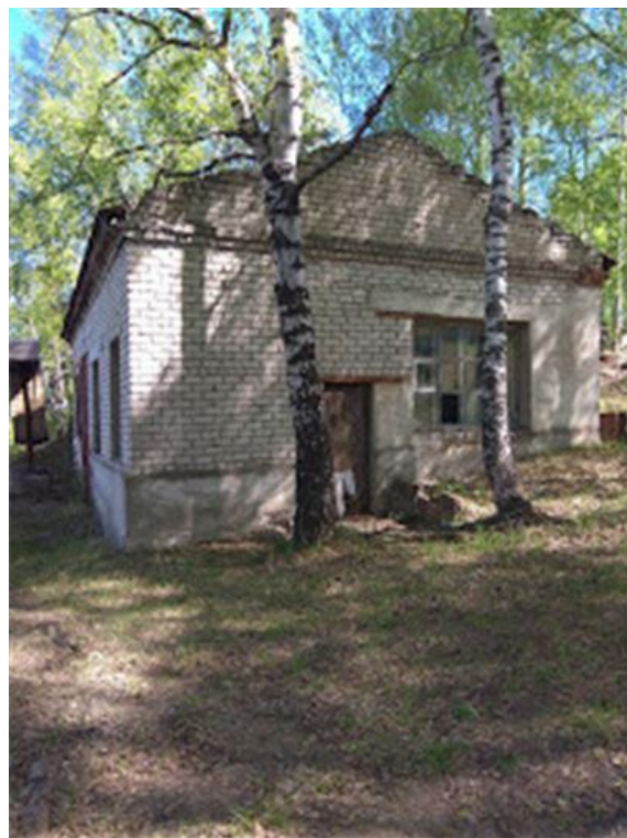
Фото.2 Здание компрессорной, лит.3 (2)
