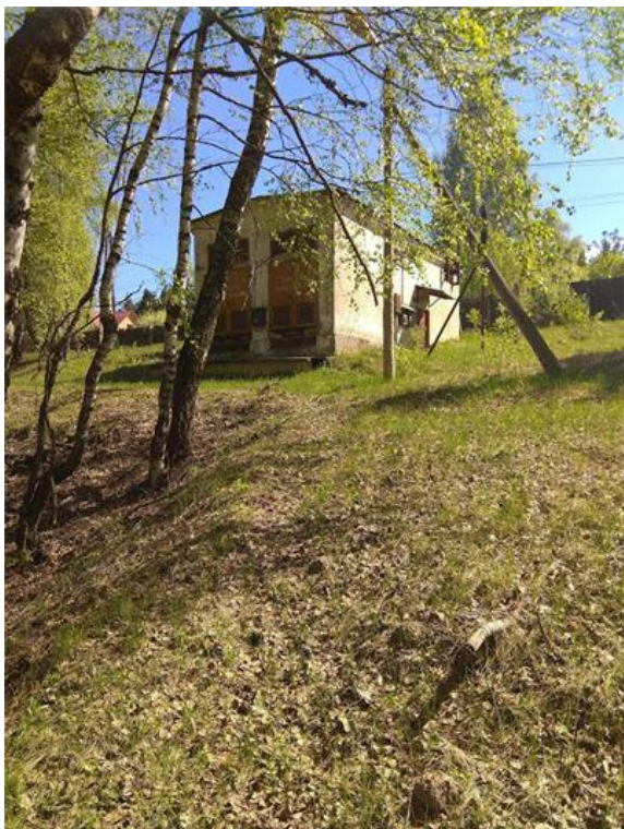
Фото.29 Здание трансформаторной подстанции, лит.Ж (1)
