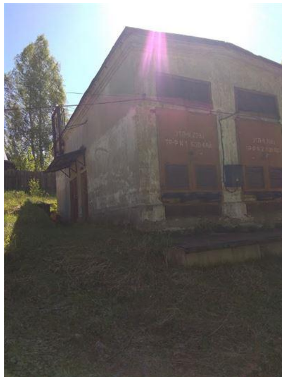
Фото.30 Здание трансформаторной подстанции, лит.Ж (2)
