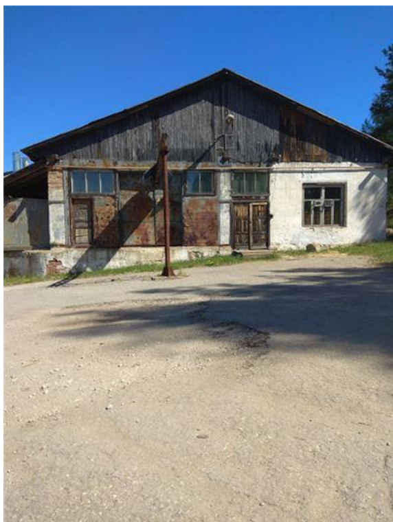
Фото.37 Здание цеха отделки кузовов, лит. М.м (3)
