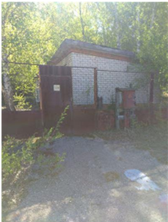
Фото.25 Здание склада ГСМ, лит.С (1)
