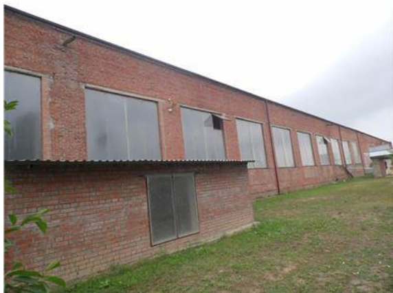
Фото.7 Литер А4, А5 Приемо-сдаточный цех
