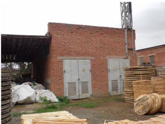
Фото.19 Литер Я Здание электростанции
