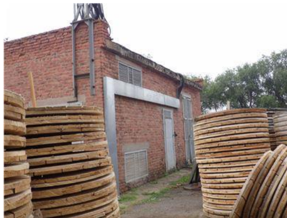
Фото.18 Литер Я Здание электростанции
