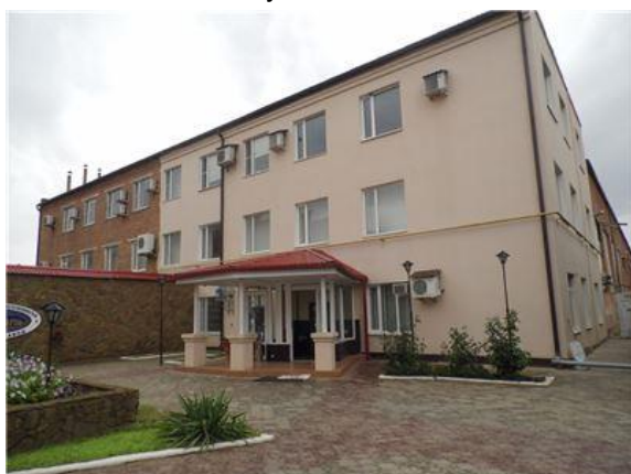
Фото.5 Литер А3 Главный корпус
