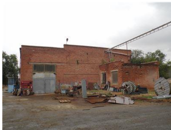
Фото.16 Литер Д,нД,д Здание производственного склада
