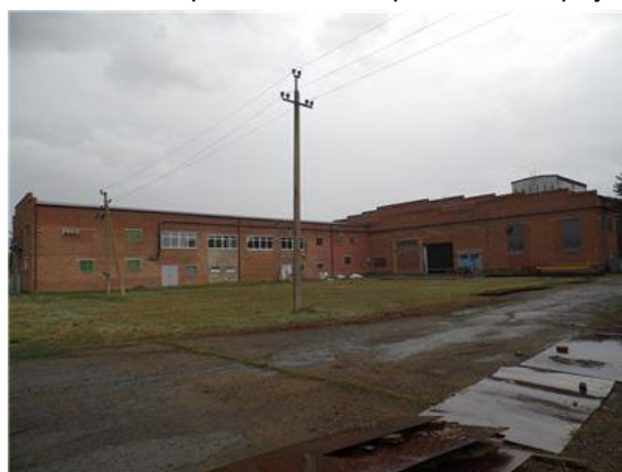
Фото.6 Литер А4, А5 Приемо-сдаточный цех
