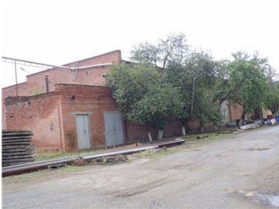
Фото.15 Литер Д,нД,д Здание производственного склада
