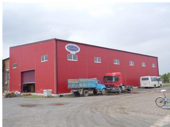
Фото.14 Литер Б Здание склада
