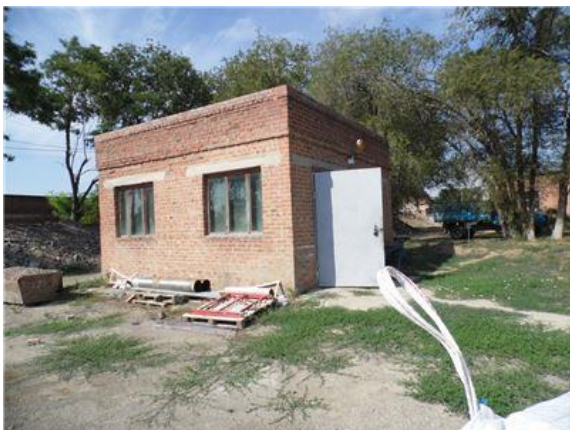
Фото.17 Литер Щ здание насосной
