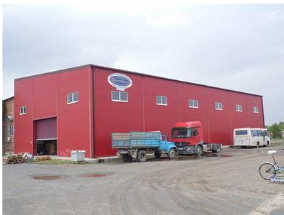
Фото.15 Лит Б Здание склада
