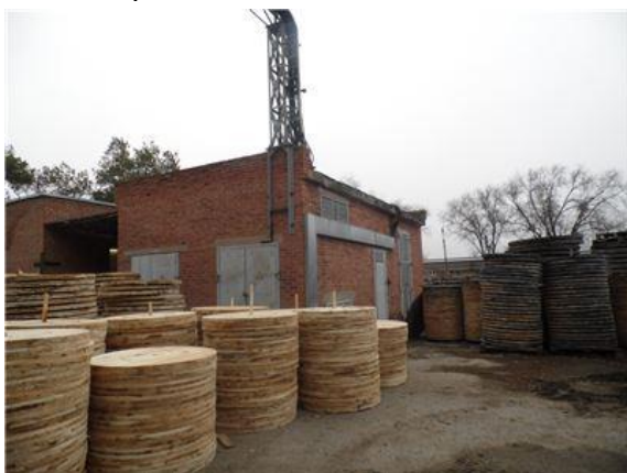
Фото.19 лит. Я здание электростанции
