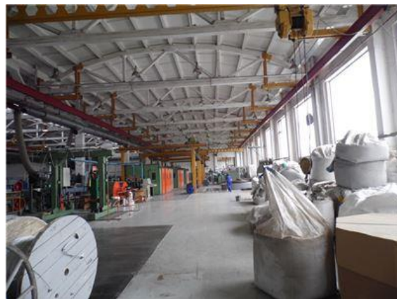
Фото.8 Лит А4, А5 Приемосдаточный цех.
