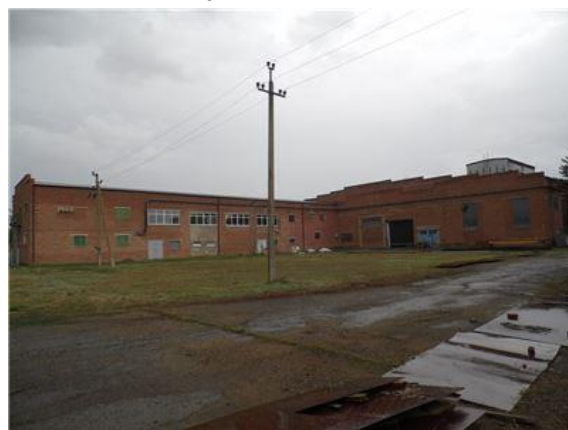
Фото.4 Лит А4, А5 Приемосдаточный цех
