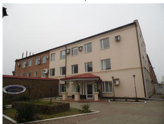
Фото.6 Лит А3 Главный корпус
