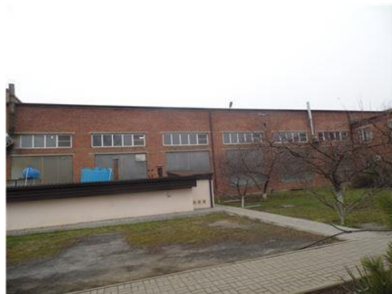
Фото.12 Лит Аа Разборочный цех
