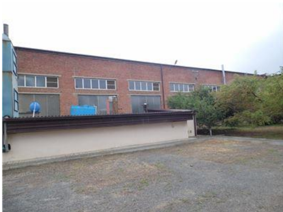
Фото.11 Лит Аа Разборочный цех
