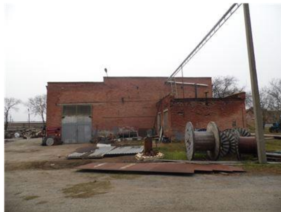
Фото.16 лит Д, нД, д Здание производственного склада
