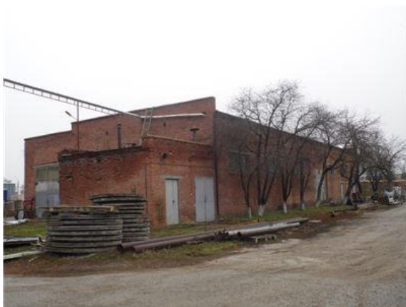
Фото.17 лит Д, нД, д Здание производственного склада
