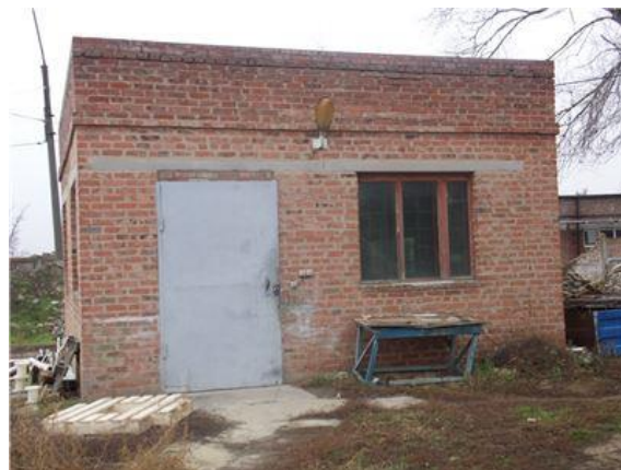
Фото.18 Лит. Щ здание насосной
