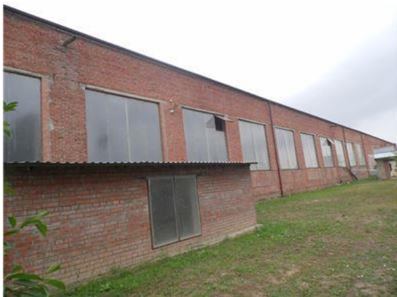
Фото.7 Лит А4, А5 Приемосдаточный цех.
