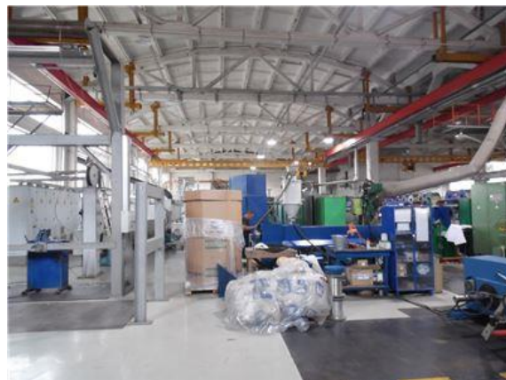
Фото.14 Лит Аа Разборочный цех
