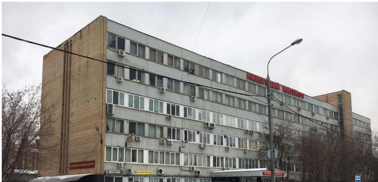
Фото.2 Внешний вид здания
