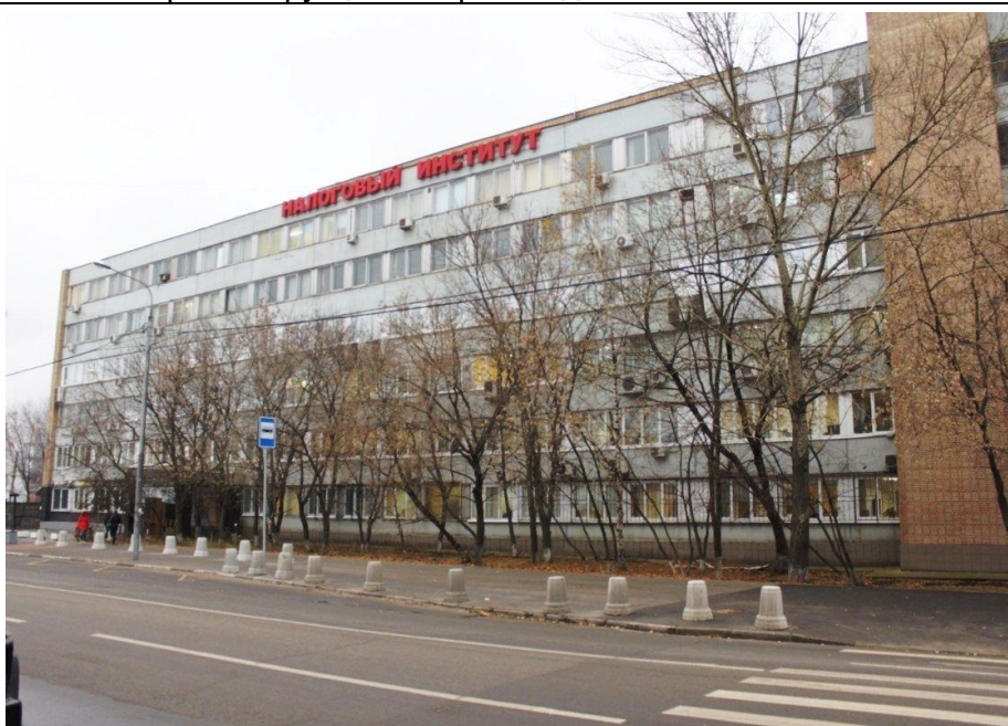
Фото.1 Внешний вид здания
