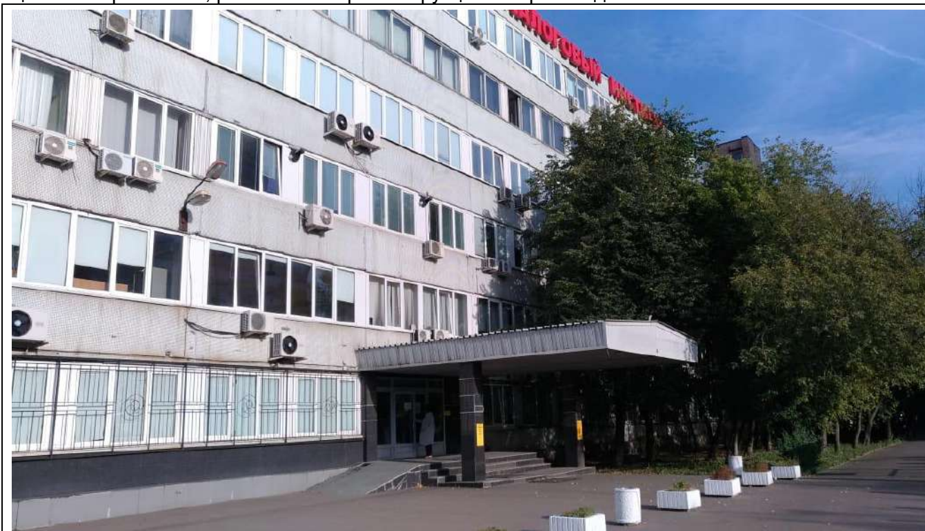
Фото.1 Внешний вид здания
