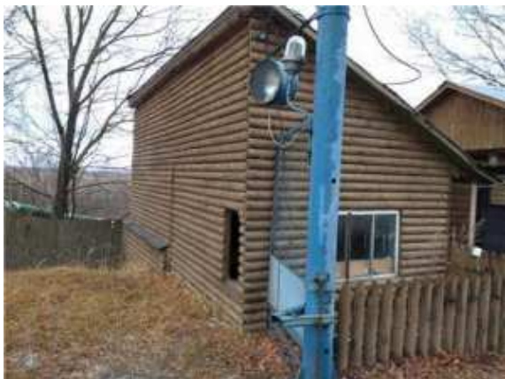
Фото.9 Здание проходной, лит.А, а (1)
