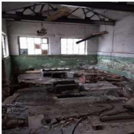
Фото.2 Здание компрессорной, лит.З (2)
