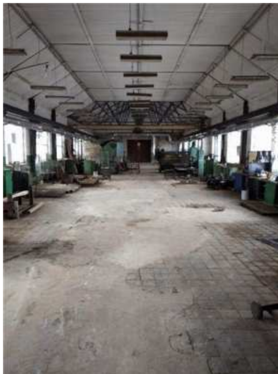
Фото.8 Здание механического цеха, лит. Н.н (2)
