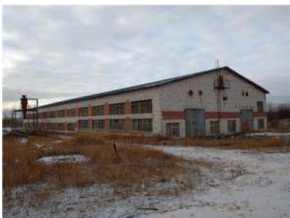
Фото.11 Здание сборочного цеха, лит. О.о (2)
