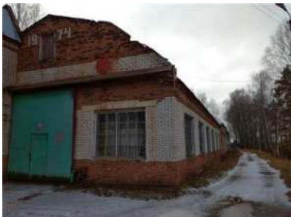
Фото.7 Здание механического цеха, лит. Н.н (1)
