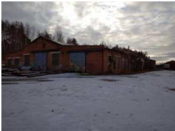
Фото.19 Здание цеха отделки кузовов, лит. М.м (1)
