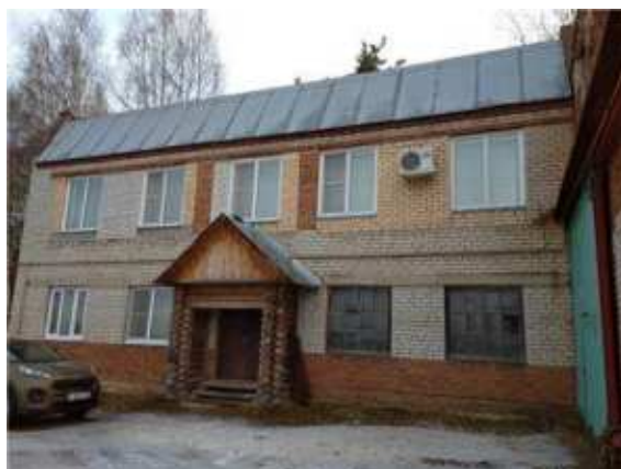
Фото.14 Здание техотдела, лит. Н1 (1)
