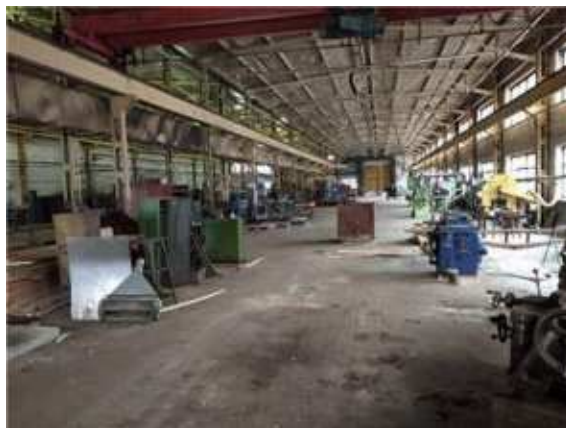
Фото.10 Здание сборочного цеха, лит. О.о (1)
