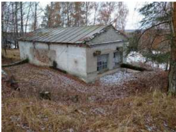
Фото.1 Здание компрессорной, лит.З (1)
