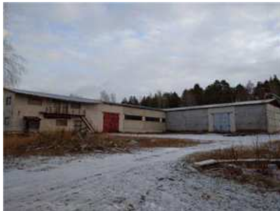
Фото.6 Здание материального склада, лит. Р.Р1.р (2)
