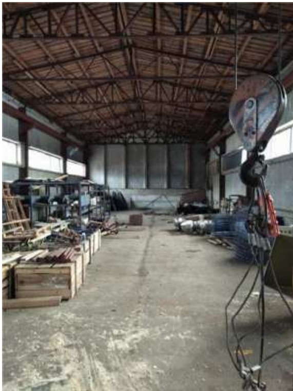
Фото.5 Здание материального склада, лит. Р.Р1.р (1)
