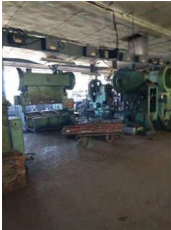
Фото.20 Здание цеха отделки кузовов, лит. М.м (2)
