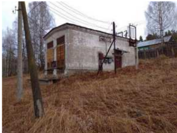
Фото.16 Здание трансформаторной подстанции, лит.Ж (1)
