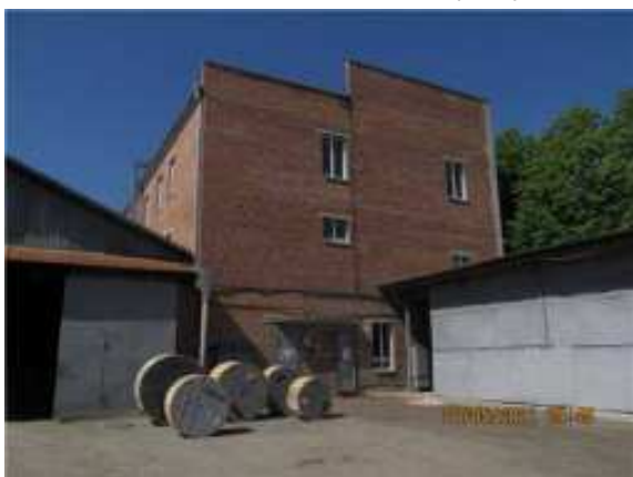
Фото.11 Литер Д (Лабораторно-бытовой корпус) (2)
