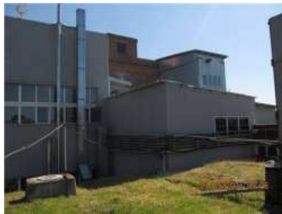
Фото.34 Литер С (Здание ОВК) (1)
