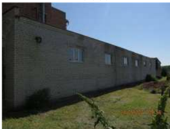
Фото.12 Литер Д (Лабораторно-бытовой корпус) (3)
