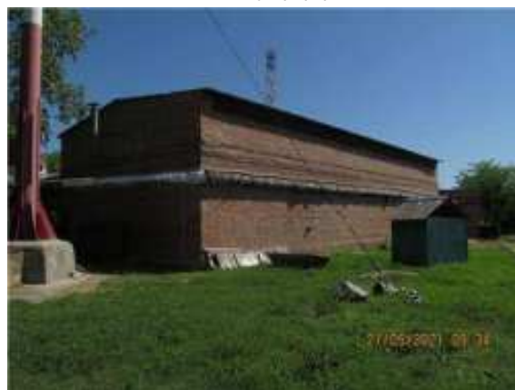
Фото.32 Литер Р (Трубный склад) (2)
