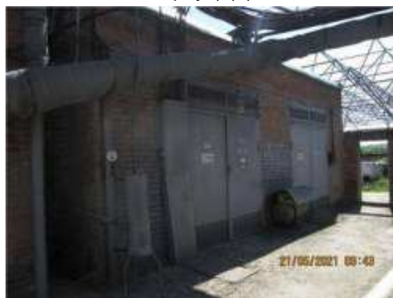
Фото.30 Литер О (Лабораторно-бытовой корпус) (2)
