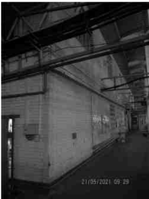
Фото.35 Литер С (Здание ОВК) (2)
