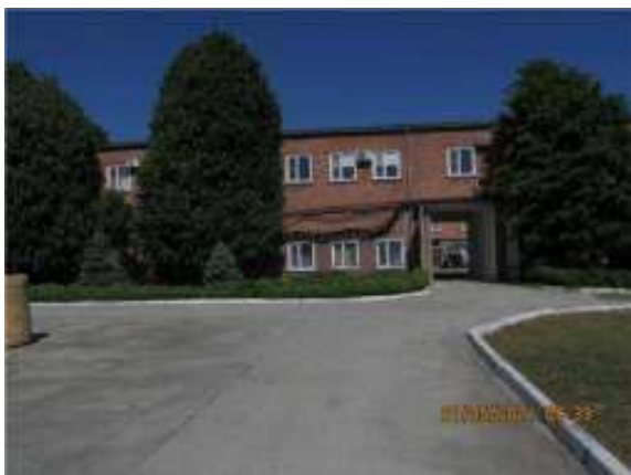
Фото.9 Литер В (Административно-хозяйственное здание) 23)
