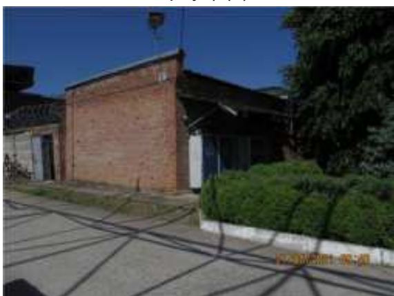
Фото.29 Литер О (Лабораторно-бытовой корпус) (1)
