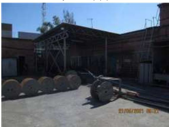
Фото.23 Литер К (Склад и Линейный участок)Литер К (Склад и Линейный участок) (1)
