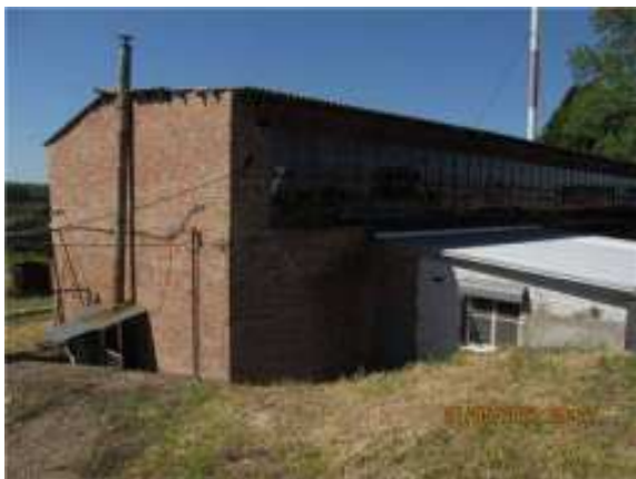
Фото.33 Литер Р (Трубный склад) (3)
