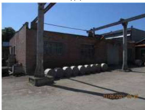
Фото.26 Литер М (Лабораторно-бытовой корпус) (2)
