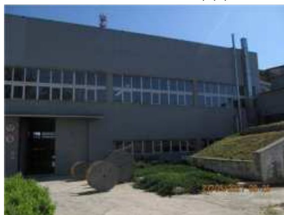
Фото.42 Литер Х (Нежилое здание - цех) (1)
