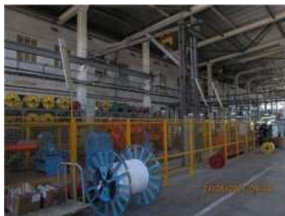
Фото.38 Литер Т (Здание слесарно-механического цеха) (2)
