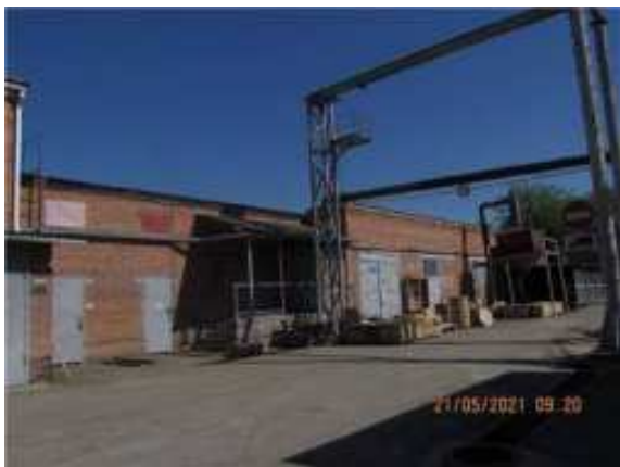
Фото.7 Литер Б (Учебно-производственный корпус) (2)
