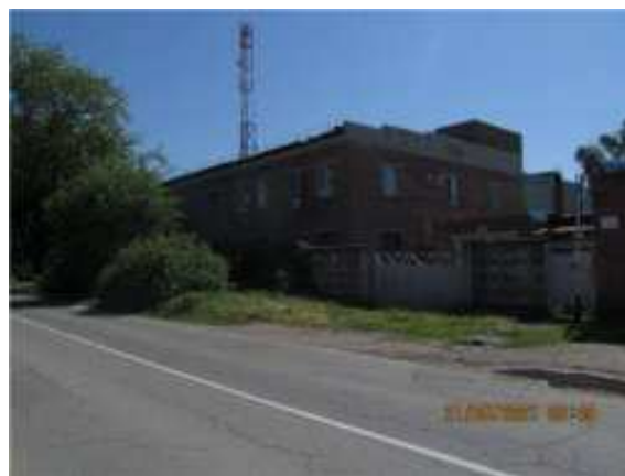
Фото.40 Литер Т (Здание слесарно-механического цеха) (4)
