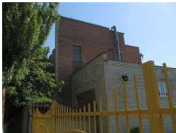
Фото.10 Литер Д (Лабораторно-бытовой корпус) (1)
