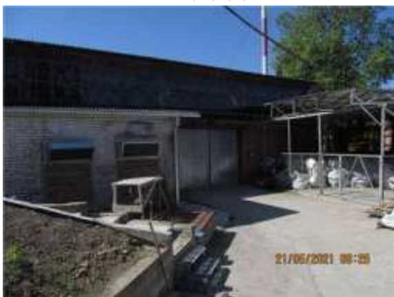
Фото.31 Литер Р (Трубный склад) (1)
