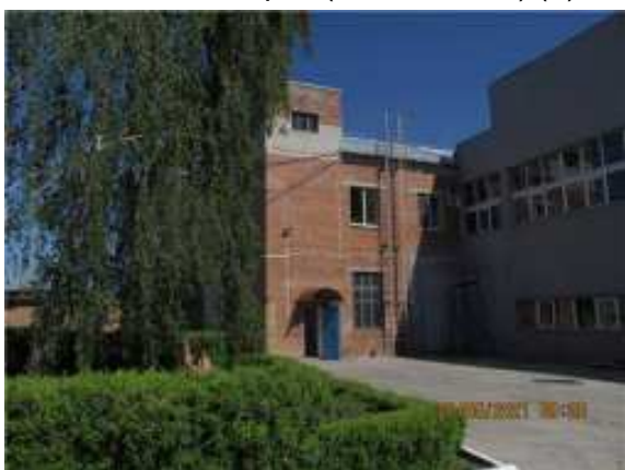
Фото.37 Литер Т (Здание слесарно-механического цеха) (1)
