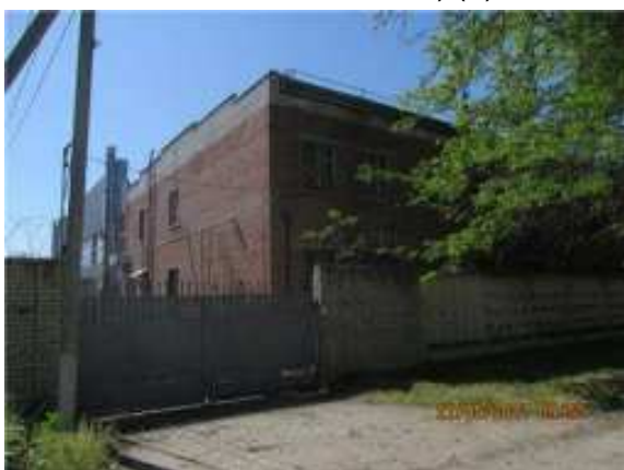
Фото.41 Литер Т (Здание слесарно-механического цеха) (5)
