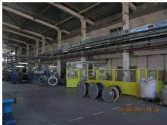
Фото.36 Литер С (Здание ОВК) (3)
