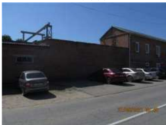
Фото.6 Литер Б (Учебно-производственный корпус) (1)
