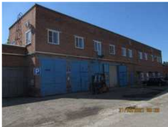
Фото.8 Литер В (Административно-хозяйственное здание) (1)
