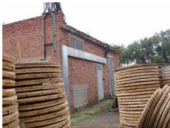
Фото.18 Литер Я Здание электростанции
