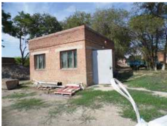
Фото.17 Литер Щ здание насосной
