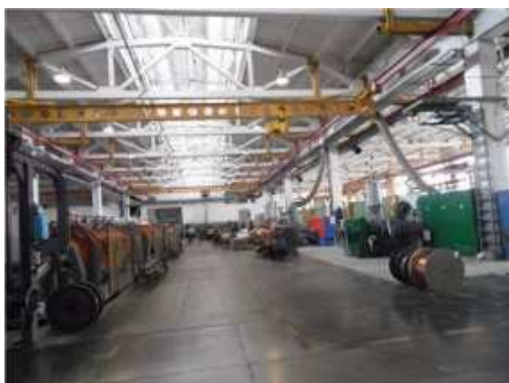
Фото.9 Литер А4, А5 Приемо-сдаточный цех
