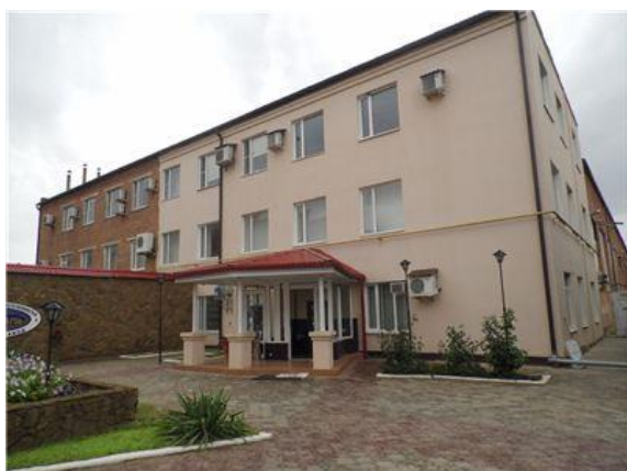
Фото.5 Литер А3 Главный корпус
