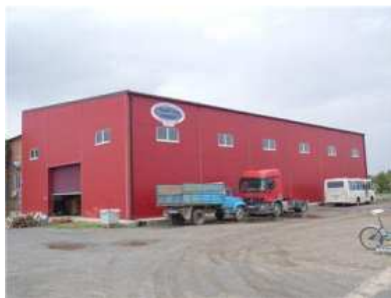
Фото.14 Литер Б Здание склада
