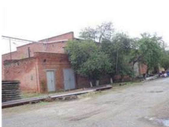
Фото.15 Литер Д,нД,д Здание производственного склада
