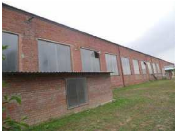
Фото.7 Литер А4, А5 Приемо-сдаточный цех
