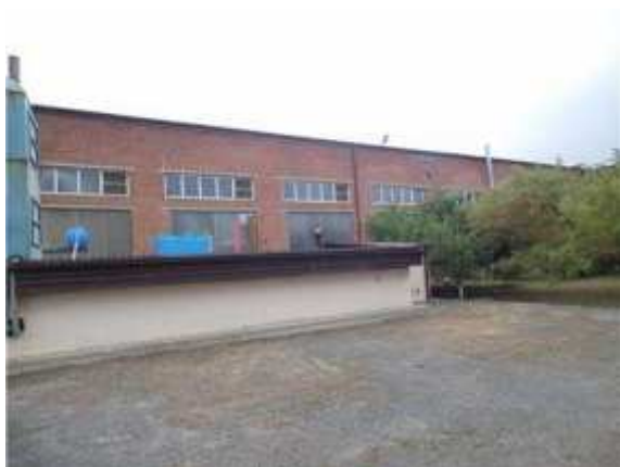
Фото.11 Литер Аа Разборочный цех
