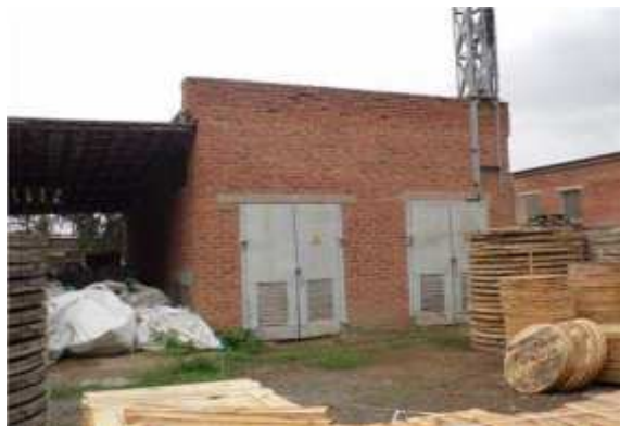
Фото.19 Литер Я Здание электростанции
