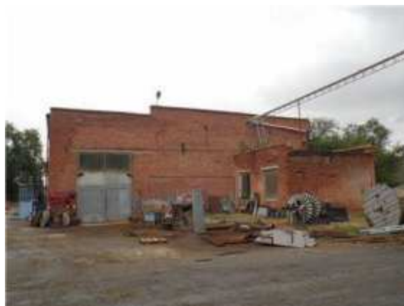
Фото.16 Литер Д,нД,д Здание производственного склада
