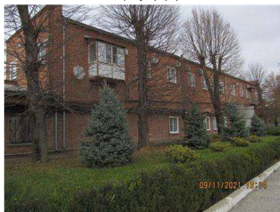
Фото.10 Литер В (Административно-хозяйственное здание) (2)
