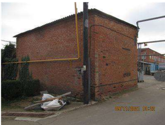
Фото.15 Литер Д1 (Склад) (2)
