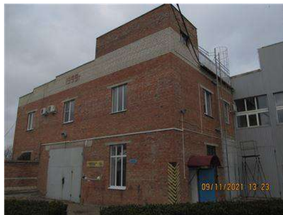
Фото.38 Литер Т (Здание слесарно-механического цеха) (4)
