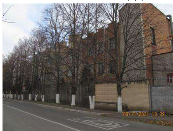
Фото.12 Литер Д (Лабораторно-бытовой корпус) (1)
