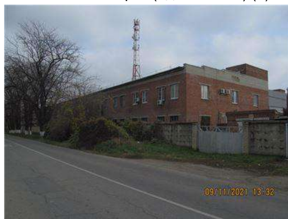
Фото.36 Литер Т (Здание слесарно-механического цеха) (2)
