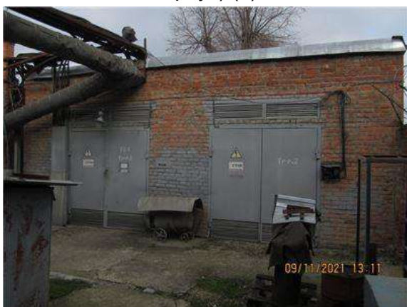
Фото.29 Литер О (Лабораторно-бытовой корпус) (1)
