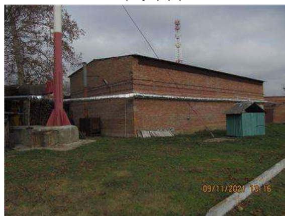
Фото.30 Литер Р (Трубный склад) (1)
