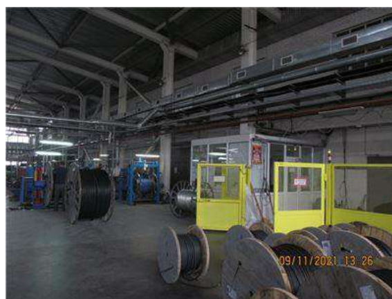
Фото.32 Литер С (Здание ОВК) (1)
