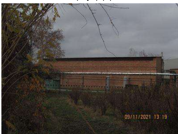
Фото.31 Литер Р (Трубный склад) (2)
