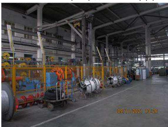
Фото.35 Литер Т (Здание слесарно-механического цеха) (1)
