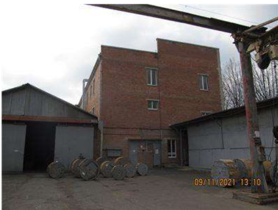
Фото.13 Литер Д (Лабораторно-бытовой корпус) (2)
