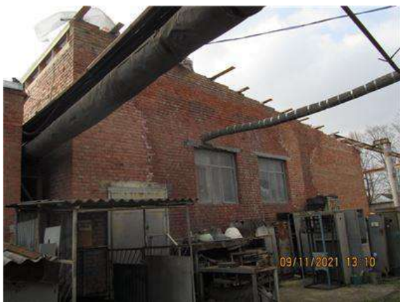
Фото.27 Литер М (Лабораторно-бытовой корпус) (2)
