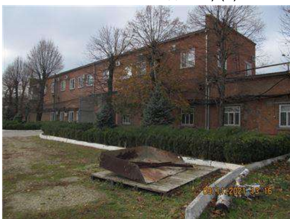
Фото.11 Литер В (Административно-хозяйственное здание) (3)
