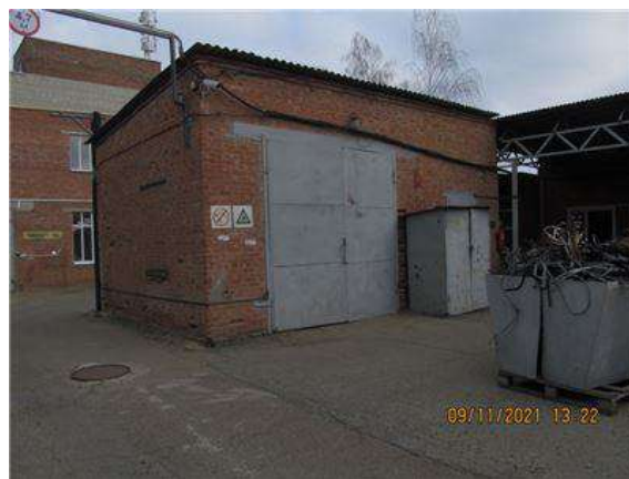
Фото.14 Литер Д1 (Склад) (1)
