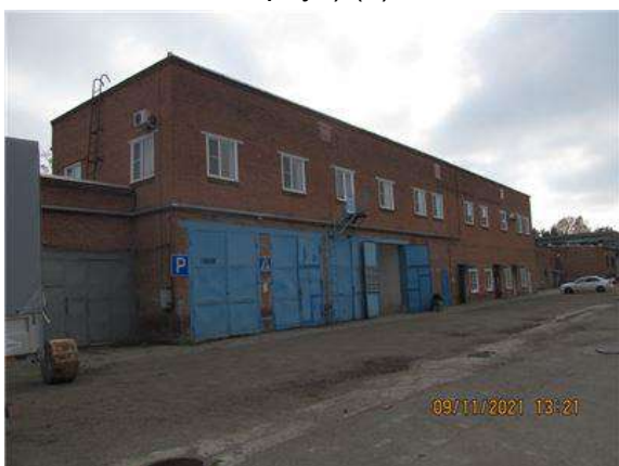
Фото.9 Литер В (Административно-хозяйственное здание) (1)
