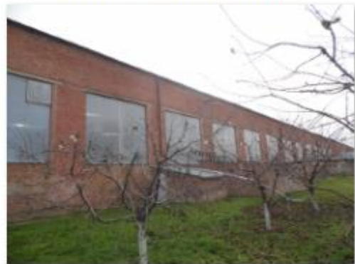
Литер А4,А5 Приемно -сдаточный цех
