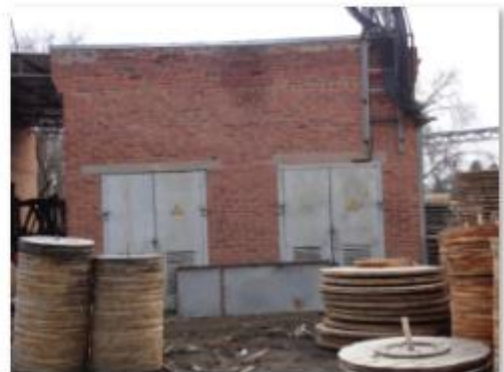
Литер Я здание электростанции
