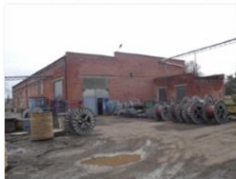
Литер Д, нД д Здание производственного склада
