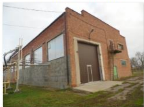
Литер А4,А5 Приемно-сдаточный цех
