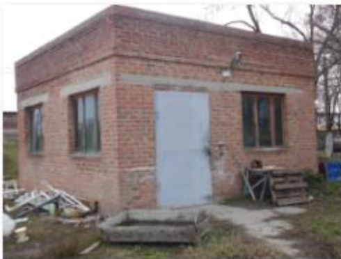
Литер Щ Здание насосной
