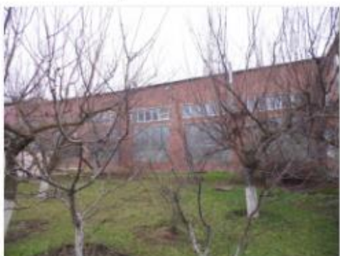
Литер Аа Разборочный цех
