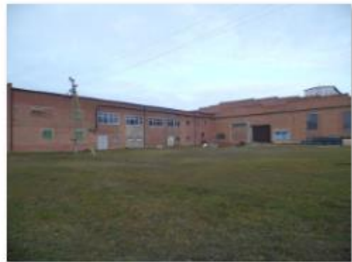
Литер А4,А5 Приемно-сдаточный цех
