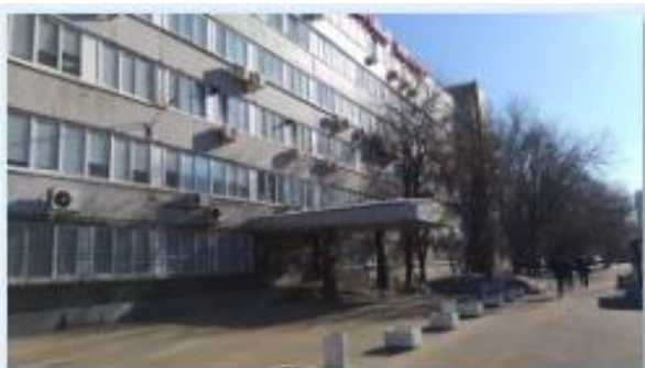
Вид здания. Входная группа
