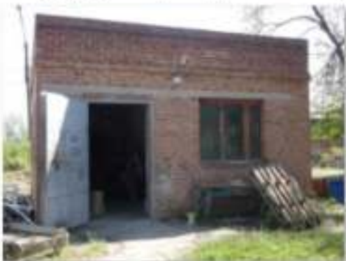
Литер Щ Здание Насосной
