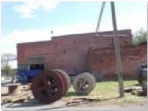
Лит. ДнДд Здание производственного склада
