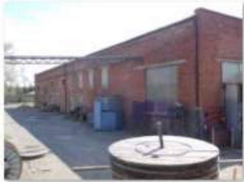
Лит. ДнДд Здание производственного склада
