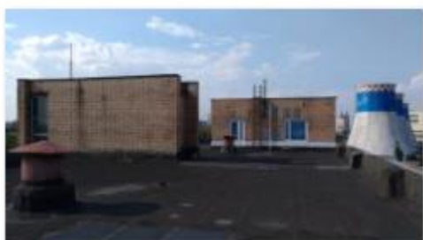
Внешний вид объекта (5)
