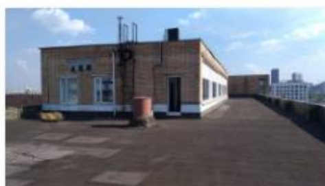
Внешний вид объекта (4)
