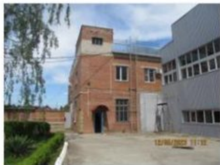
Литер Т (Здание слесарно-механического цеха) (2)
