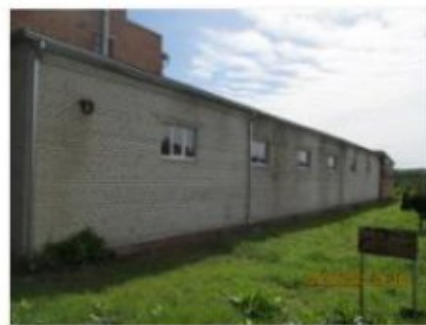
Литер Д (Лабораторно-бытовой корпус) (3)
