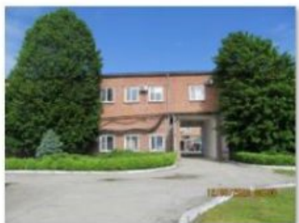
Литер В (Административно-хозяйственное здание) (1)
