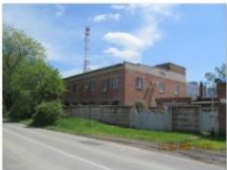
Литер Т (Здание слесарно-механического цеха) (1)
