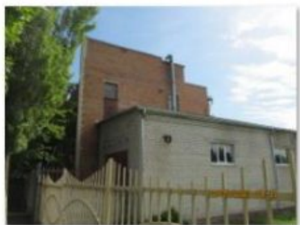
Литер Д (Лабораторно-бытовой корпус) (2)
