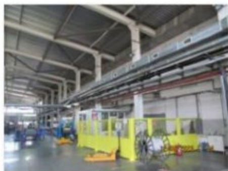
Литер С (Здание ОВК) (2)
