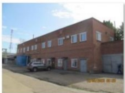
Литер В (Административно-хозяйственное здание) (3)
