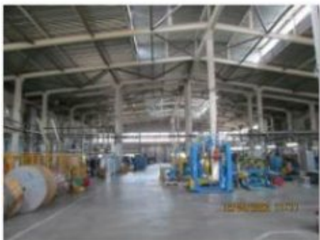
Литер Х (Нежилое здание - цех) (2)
