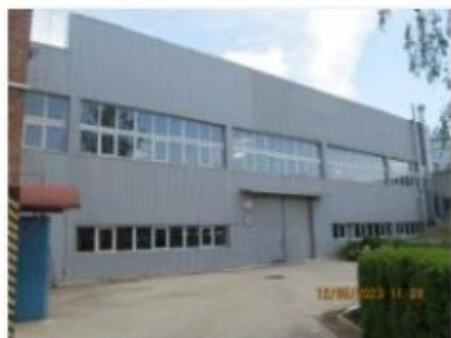
Литер Х (Нежилое здание - цех) (1)
