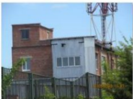
Литер С (Здание ОВК) (1)
