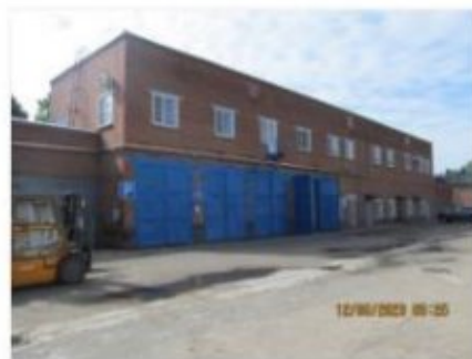
Литер В (Административно-хозяйственное здание) (2)
