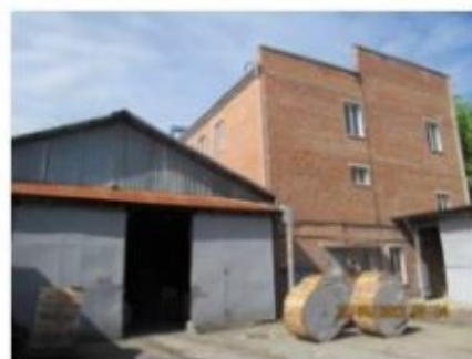
Литер Д (Лабораторно-бытовой корпус) (1)
