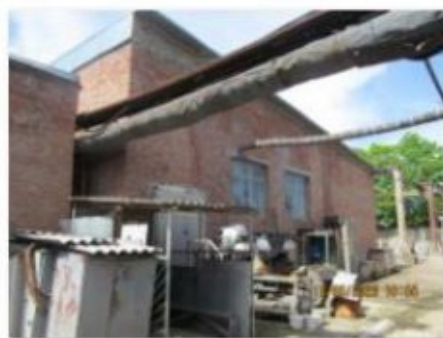
Литер М (Лабораторно-бытовой корпус) (2)
