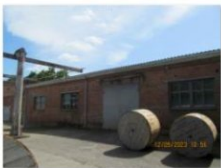
Литер М (Лабораторно-бытовой корпус) (1)
