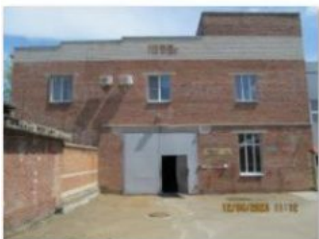
Литер Т (Здание слесарно-механического цеха) (3)
