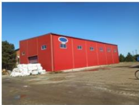
Лит. Б Здание склада
