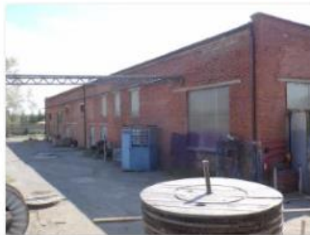
Лит. Д,нД,д Здание производственного склада
