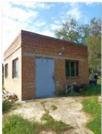
Литер Щ Здание Насосной
