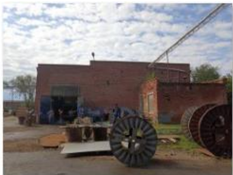
Лит. Д,нД,д Здание производственного склада
