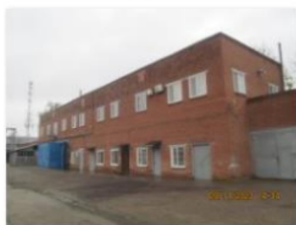
Литер В (Административно-хозяйственное здание) (2)
