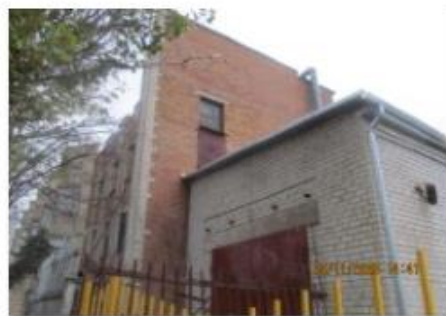
Литер Д (Лабораторно-бытовой корпус) (3)
