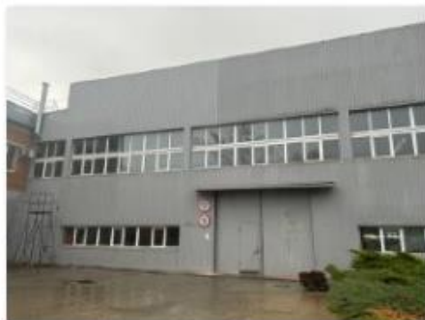
Литер Х (Нежилое здание - цех) (3)
