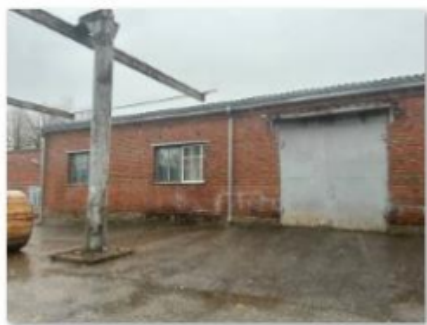
Литер М (Лабораторно-бытовой корпус) (2)
