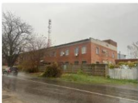
Литер Т (Здание слесарно-механического цеха) (4)
