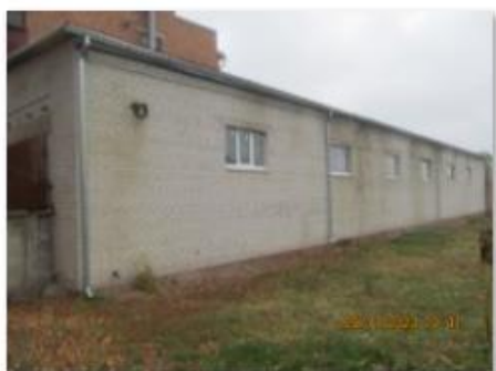
Литер Д (Лабораторно-бытовой корпус) (4)
