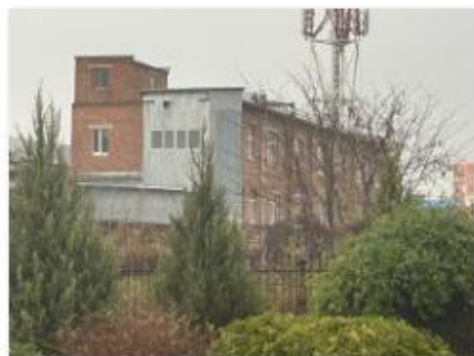
Литер С (Здание ОВК) (1)
