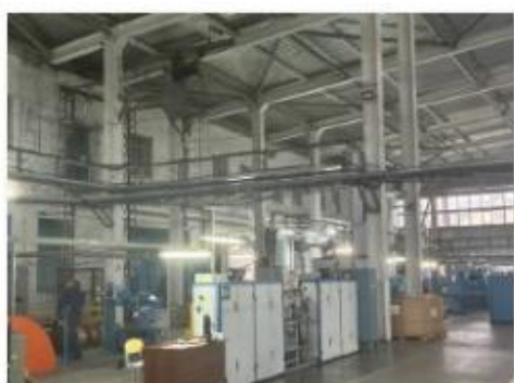
Литер Т (Здание слесарно-механического цеха) (2)
