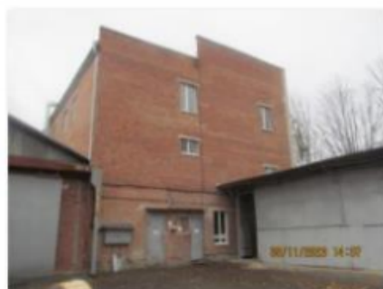
Литер Д (Лабораторно-бытовой корпус) (1)
