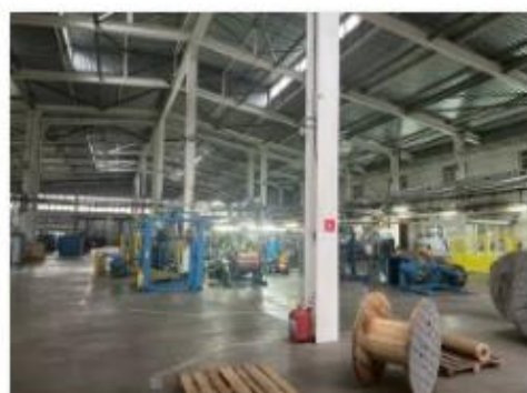
Литер Х (Нежилое здание - цех) (1)
