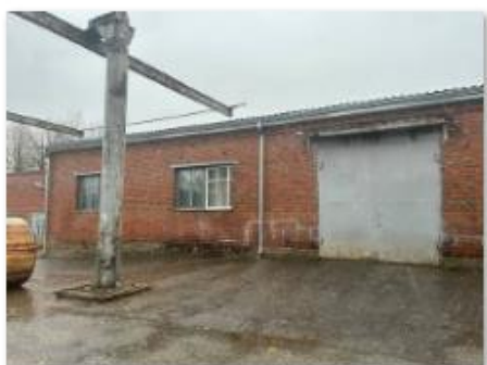
Литер М (Лабораторно-бытовой корпус) (2)
