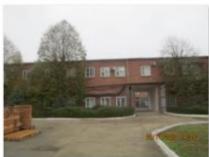
Литер В (Административно-хозяйственное здание) (3)
