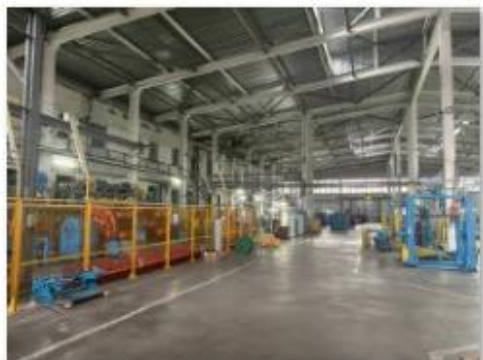
Литер Х (Нежилое здание - цех) (2)
