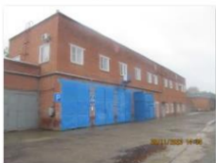
Литер В (Административно-хозяйственное здание) (1)
