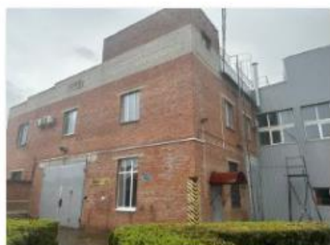
Литер Т (Здание слесарно-механического цеха) (3)
