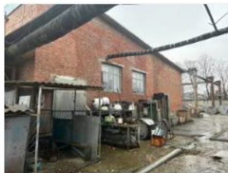
Литер М (Лабораторно-бытовой корпус) (1)
