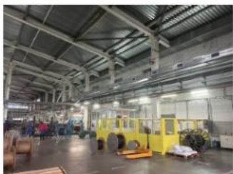
Литер С (Здание ОВК) (2)
