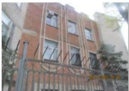
Литер Д (Лабораторно-бытовой корпус) (2)
