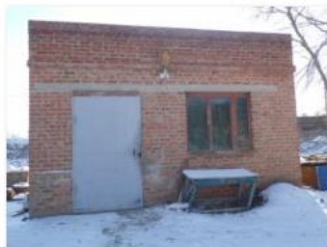
Литер Щ Здание насосной
