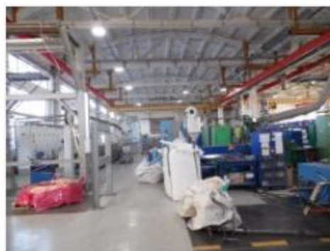
Литер Аа Разборочный цех
