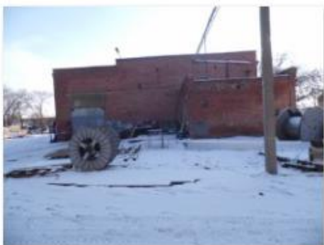
Литер Д,нД,д Здание производственного склада
