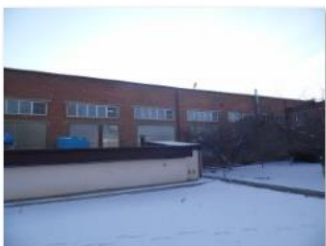
Литер Аа Разборочный цех
