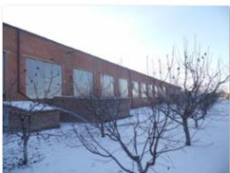
Литер А4, А5 Приемо- сдаточный цех
