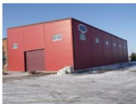
Литер Б Здание склада
