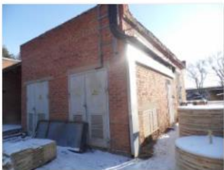
Литер Я Здание электростанции
