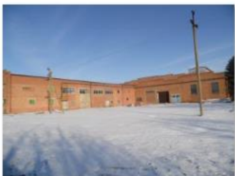
Литер А4, А5 Приемо-сдаточный цех
