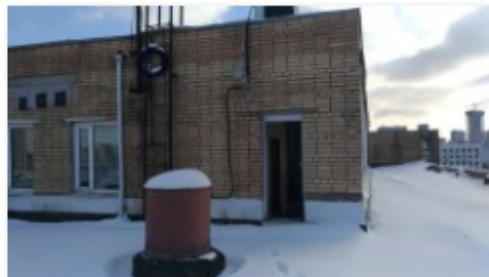
2 Внешний вид с крыши (1)
