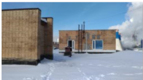
2 Внешний вид с крыши (2)
