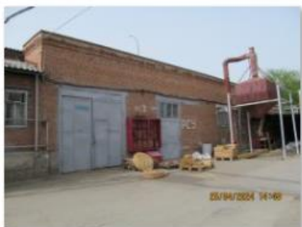
Литер Б (Учебно-производственный корпус) (4)
