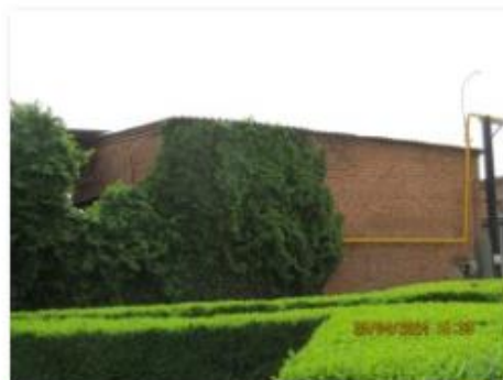
Литер Д1 (Склад) (2)
