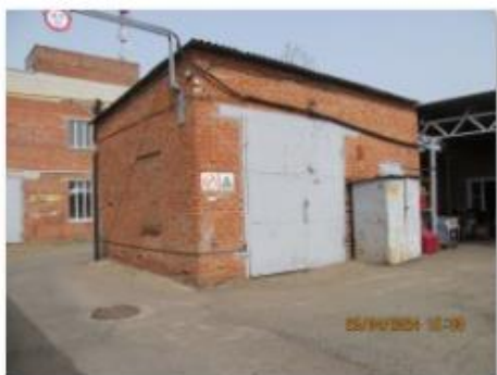
Литер Д1 (Склад) (1)
