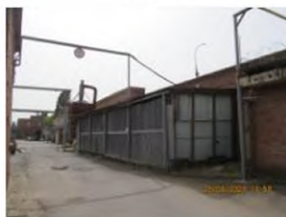
Литер Б (Учебно-производственный корпус) (1)
