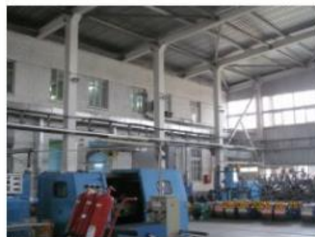
Литер Т (Здание слесарно-механического цеха) (2)
