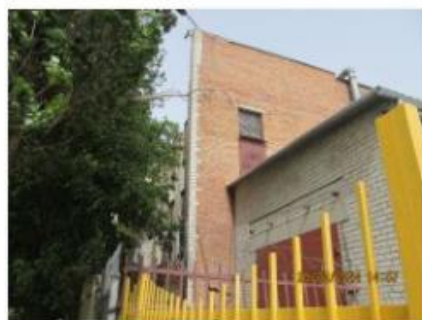
Литер Д (Лабораторно-бытовой корпус) (2)
