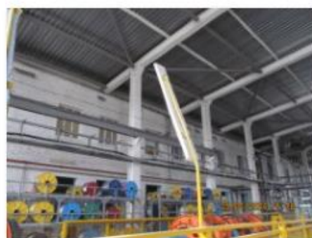
Литер Т (Здание слесарно-механического цеха) (4)
