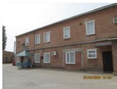
Литер А (Учебно-производственный корпус) (1)
