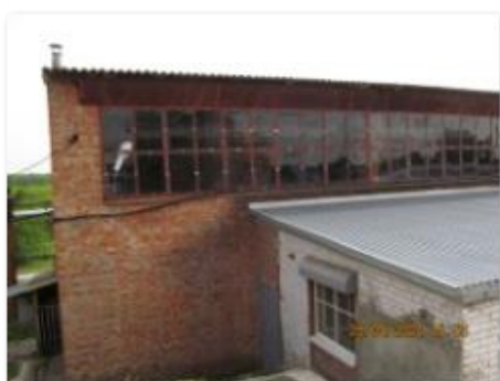
Литер Р (Трубный склад) (1)
