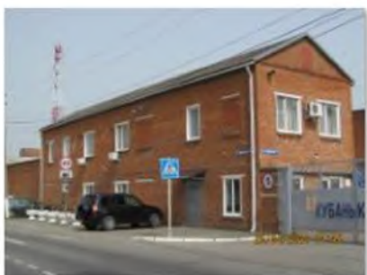
Литер А (Учебно-производственный корпус) (2)
