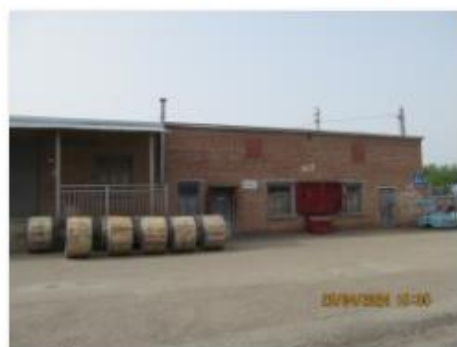
Литер Ж (Склад) (1)
