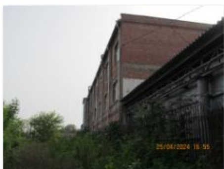
Литер С (Здание ОВК) (1)
