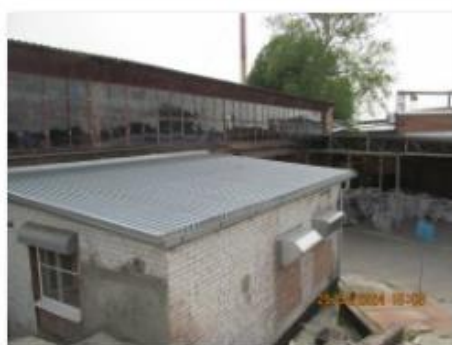
Литер Р (Трубный склад) (2)
