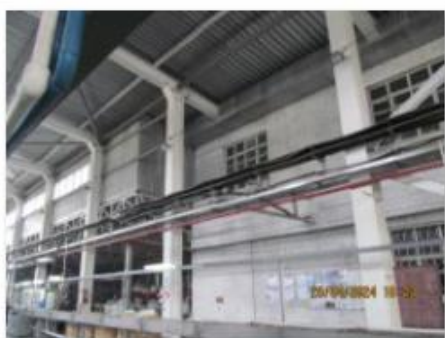
Литер С (Здание ОВК)(3)
