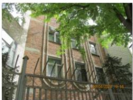
Литер Д (Лабораторно-бытовой корпус) (1)
