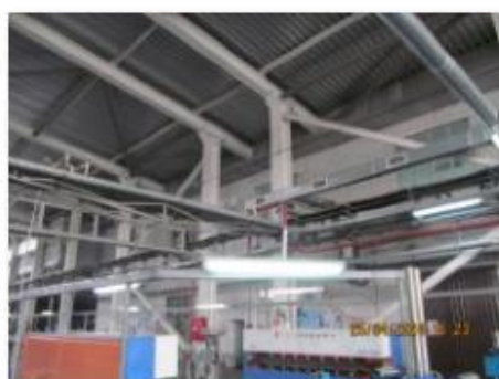
Литер С (Здание ОВК) (2)
