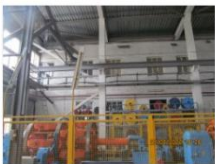
Литер Т (Здание слесарно-механического цеха) (3)
