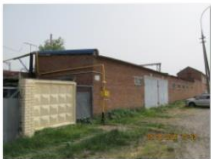
Литер Б (Учебно-производственный корпус) (2)
