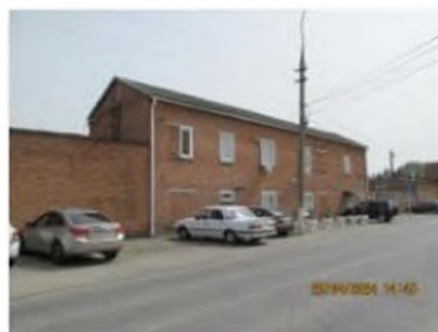
Литер А (Учебно-производственный корпус) (3)
