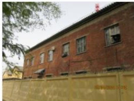
Литер Т (Здание слесарно-механического цеха) (8)
