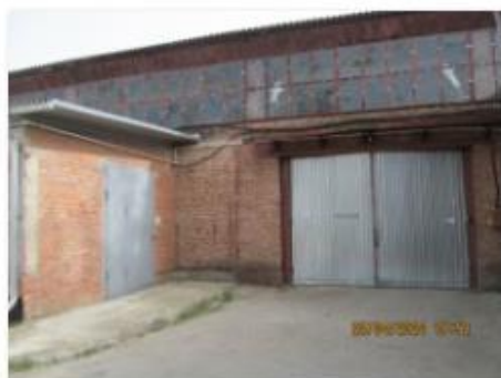
Литер Р (Трубный склад) (4)
