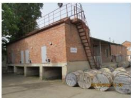
Литер Ж (Склад) (2)
