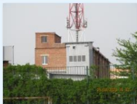
Литер С (Здание ОВК)(4)
