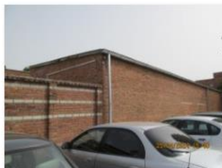
Литер Ж (Склад) (3)
