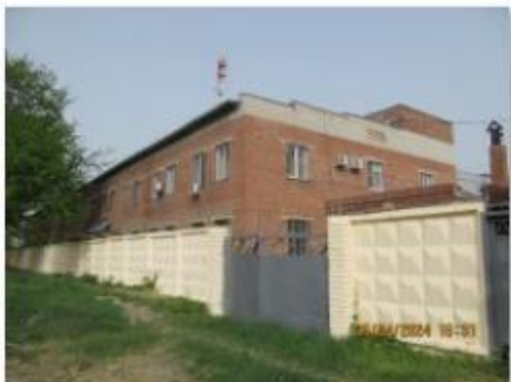
Литер Т (Здание слесарно-механического цеха) (7)
