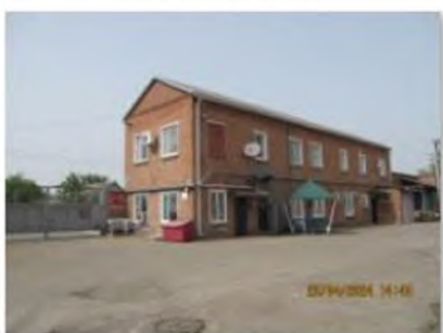
Литер А (Учебно-производственный корпус) (4)
