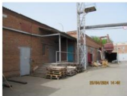
Литер Б (Учебно-производственный корпус) (3)
