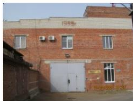
Литер Т (Здание слесарно-механического цеха) (6)
