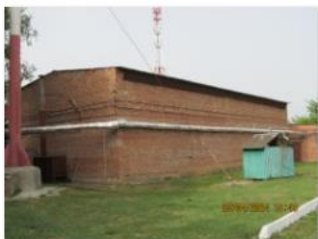
Литер Р (Трубный склад) (3)
