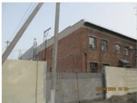
Литер Т (Здание слесарно-механического цеха) (1)
