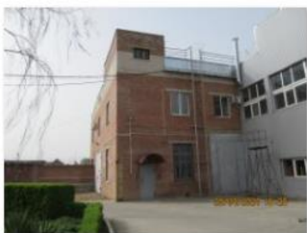
Литер Т (Здание слесарно-механического цеха) (5)
