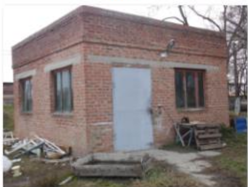
Литер Щ Здание насосной
