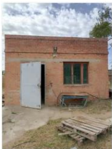
Литер Щ Здание Насосной
