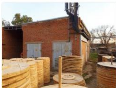
Литер Я Здание электростанции
