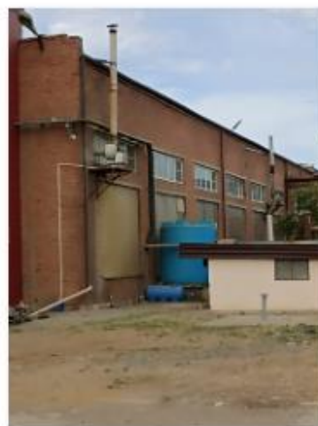
Лит. Аа Разборочный цех
