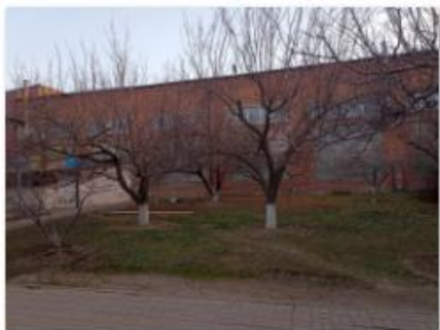
Литер Аа Разборочный цех
