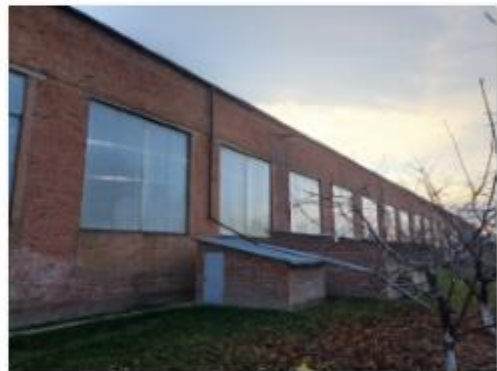
Литер А4, А5 Приемо-сдаточный цех
