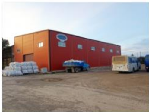
Литер Б Здание склада
