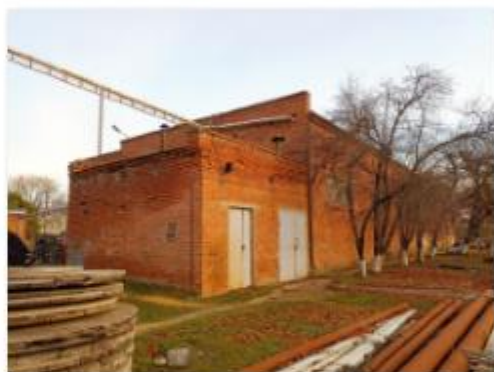
Литер ДнД д Здание Производственного склада
