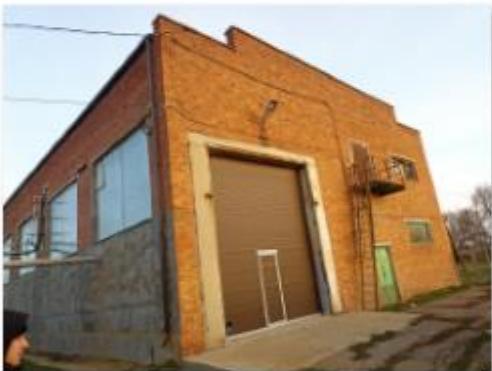
Литер А4, А5 Приемо сдаточный цех
