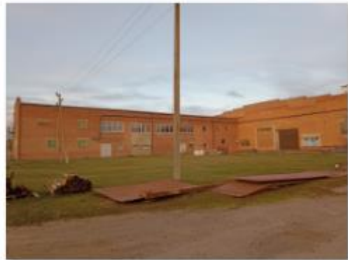
Литер А4, А5 Приемо-сдаточный цех
