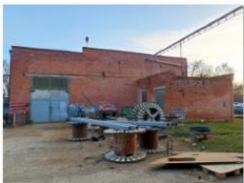
Литер ДнД д Здание Производственного склада
