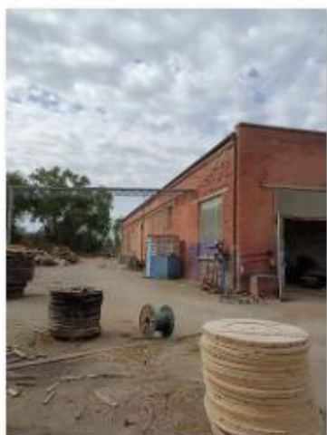
Лит. Д,нД,д Здание производственного склада
