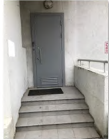
Внешний вид здания (2)
