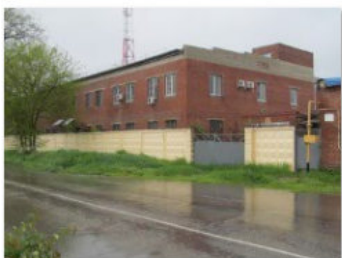
Литер Т (Здание слесарно-механического цеха) (4)
