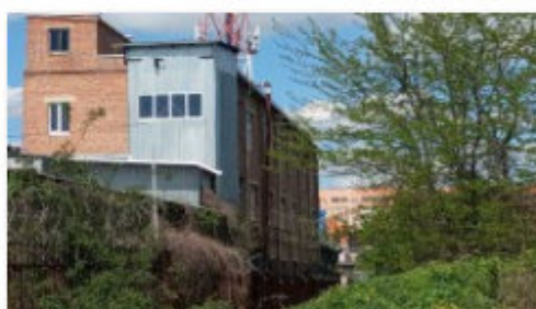
Литер С (Здание ОВК) (1)
