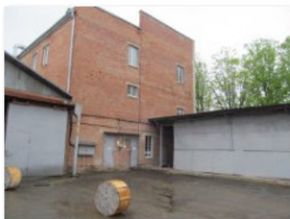
Литер Д (Лабораторно-бытовой корпус) (2)
