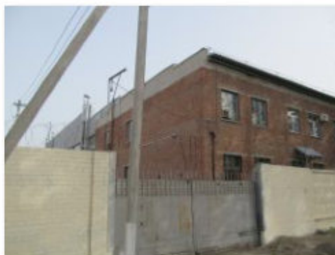
Литер Т (Здание слесарно-механического цеха) (1)
