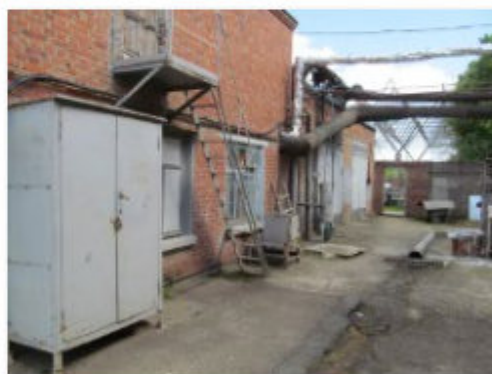
Литер 3 (Склад и Линейный участок) (4)
