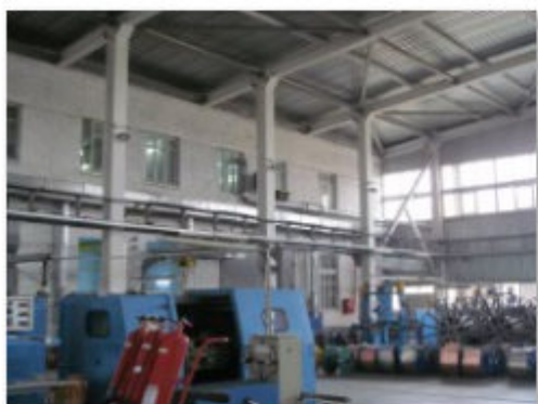
Литер Т (Здание слесарно-механического цеха) (6)
