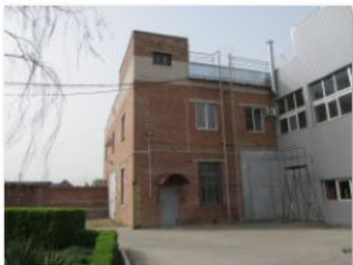
Литер Т (Здание слесарно-механического цеха) (2)
