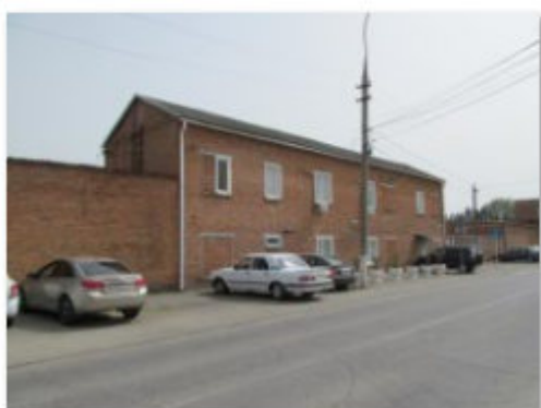
Литер А (Учебно-производственный корпус) (1)
