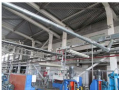
Литер С (Здание ОВК) (3)
