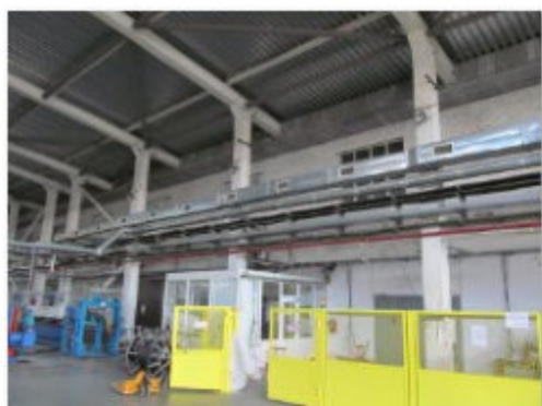
Литер С (Здание ОВК) (2)
