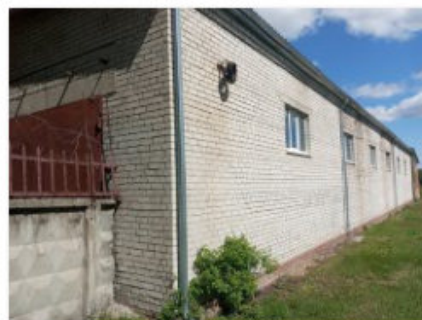
Литер Д (Лабораторно-бытовой корпус) (1)
