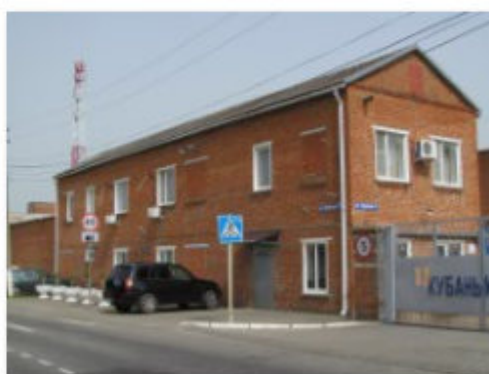
Литер А (Учебно-производственный корпус) (2)
