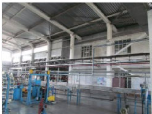
Литер С (Здание ОВК) (4)
