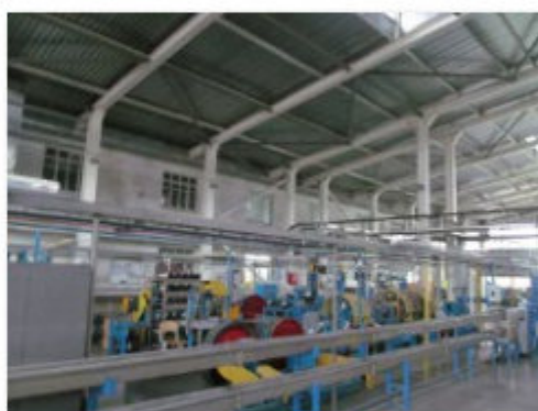
Литер Т (Здание слесарно-механического цеха) (5)
