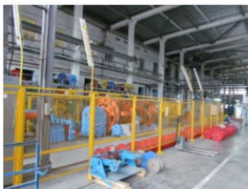
Литер Т (Здание слесарно-механического цеха) (7)
