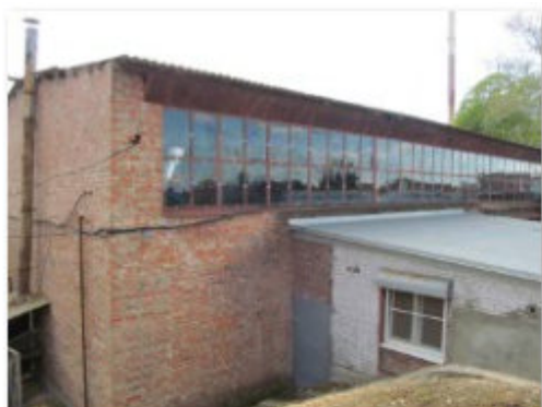
Литер Р (Трубный склад) (2)
