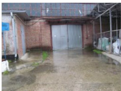
Литер Р (Трубный склад) (4)
