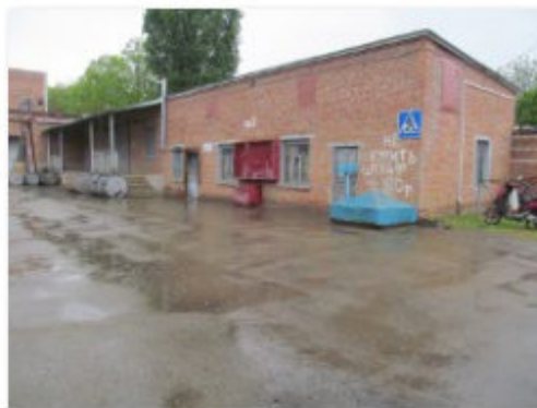
Литер Ж (Склад) (1)
