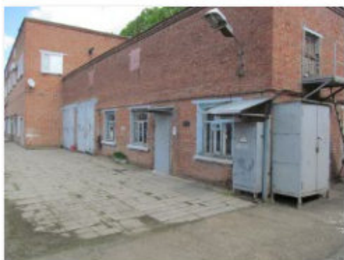
Литер 3 (Склад и Линейный участок) (3)
