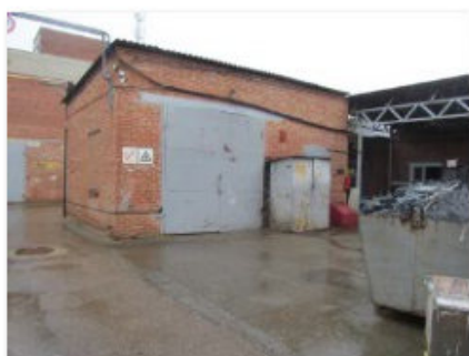
Литер Д1 (Склад) (1)
