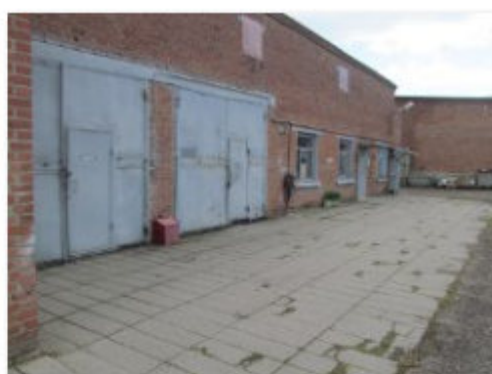
Литер 3 (Склад и Линейный участок) (2)
