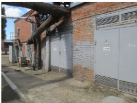
Литер 3 (Склад и Линейный участок) (5)
