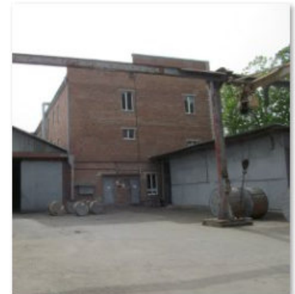
Литер Д (Лабораторно-бытовой корпус) (3)
