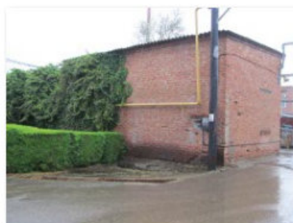
Литер Д1 (Склад) (2)
