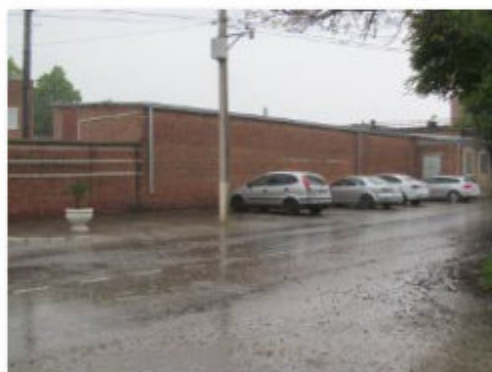
Литер Ж (Склад) (3)
