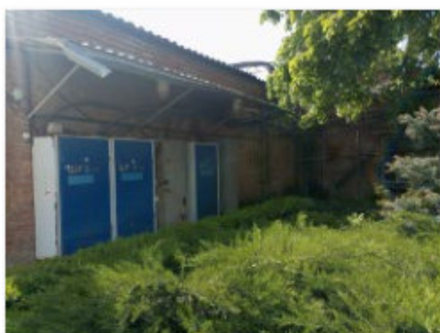
Литер 3 (Склад и Линейный участок) (1)
