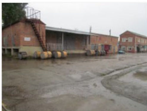
Литер Ж (Склад) (2)
