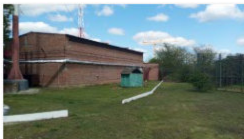
Литер Р (Трубный склад) (3)
