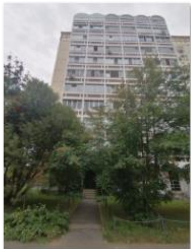
Фото 1. Внешний вид здания
